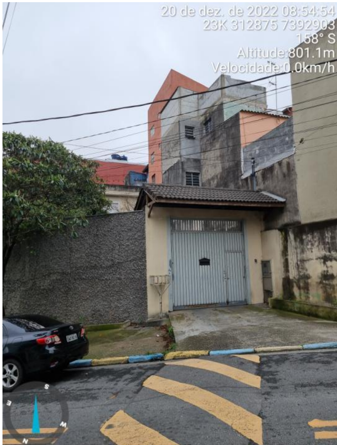
Fotografia 01: Vista parcial do muro e do portão de entrada acerca do imóvel penhorado nestes autos.
