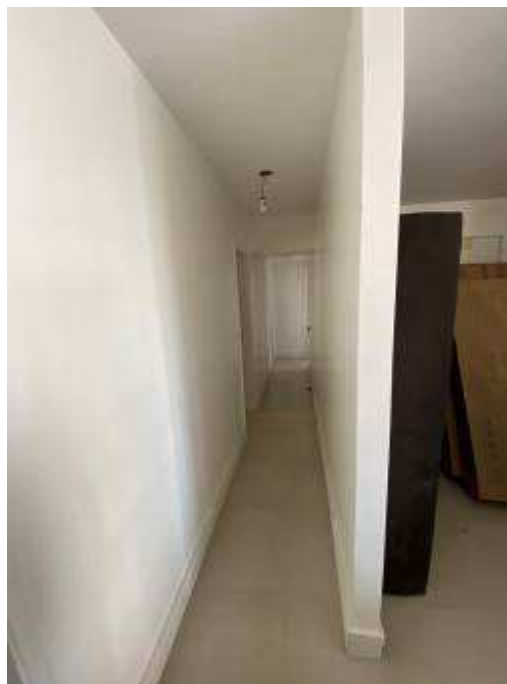
VISTA DO CORREDOR DE ACESSO AOS DORMITÓRIOS.
