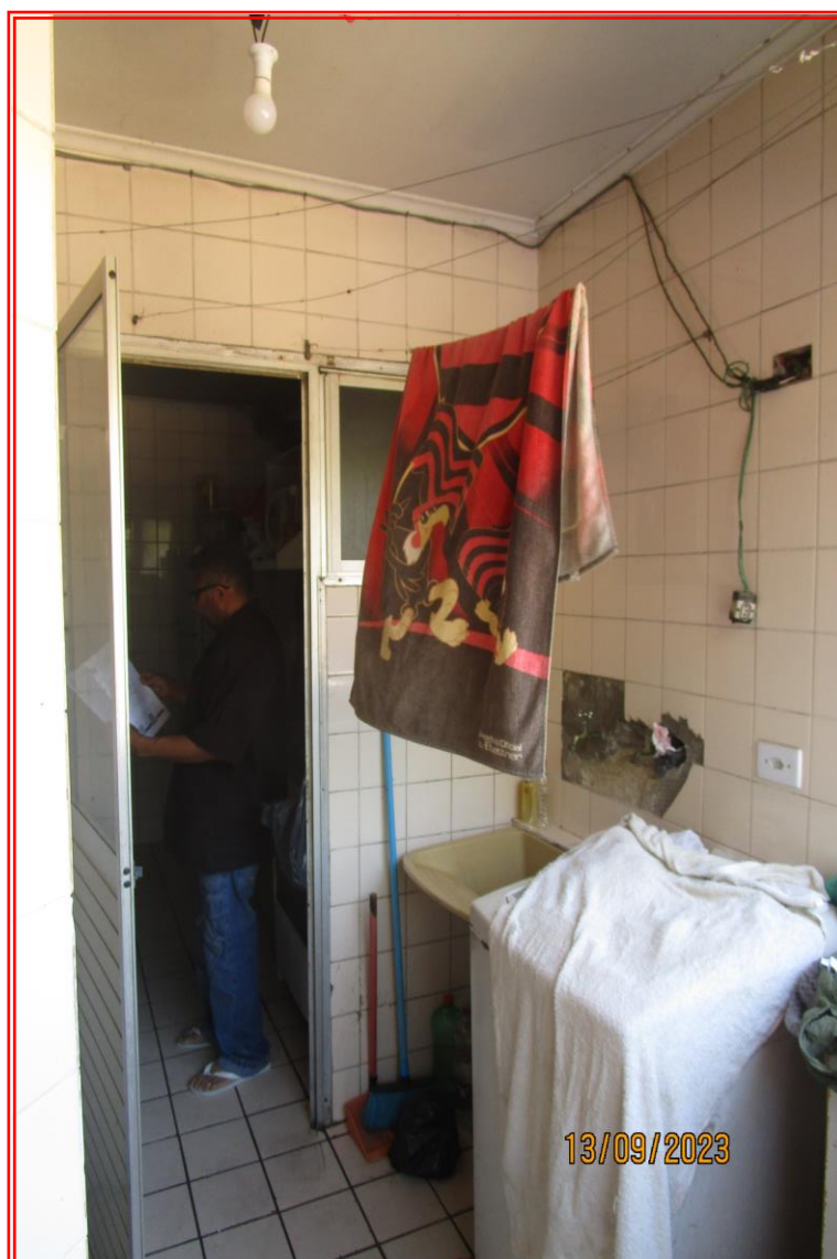
Foto nº 27: Vista parcial da área de serviço.
