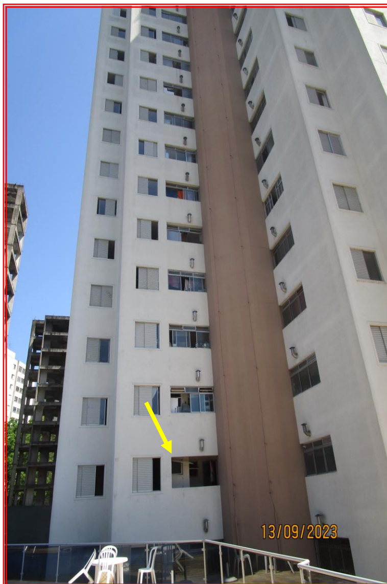
Foto nº 11: Vista geral do Bloco I, com detalhe para o apartamento nº 14, objeto da avaliação.
