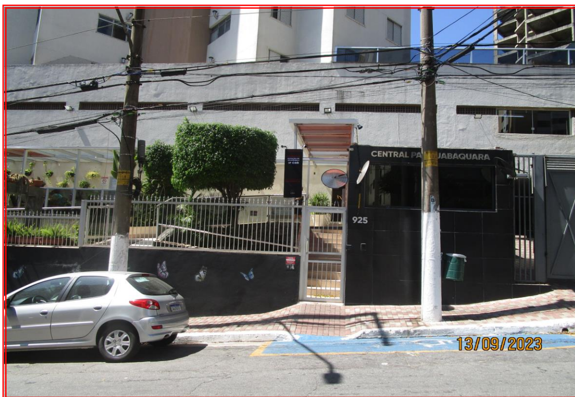
Foto nº 03: Vista geral da portaria central do condomínio.
