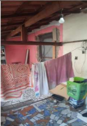
Edificação 3 - Varanda de serviço
