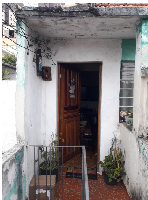
Entrada principal pavimento Superior
