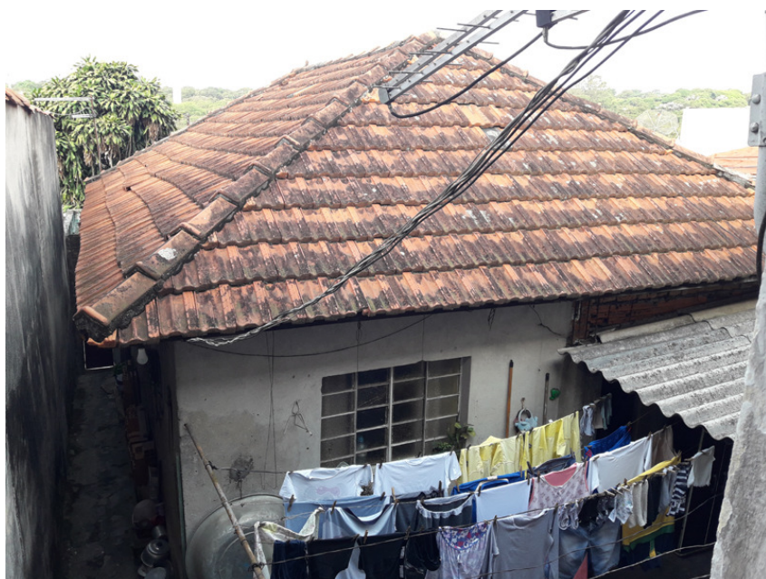
Vista Telhados / Área de Serviço
