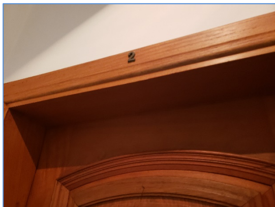
Foto 1 – Vista da porta de entrada
