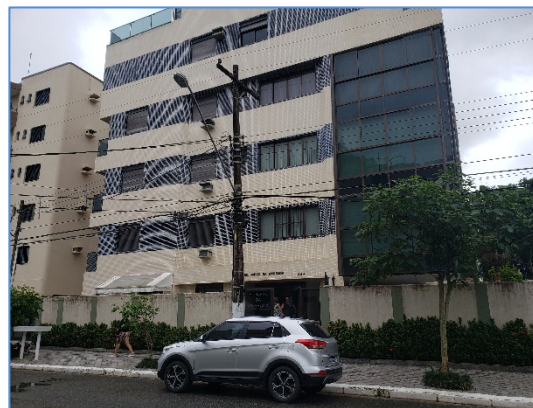
Foto 18 – Fachada frontal do edifício
