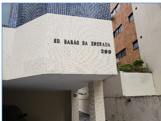
Foto 17 – Fachada frontal do edifício
