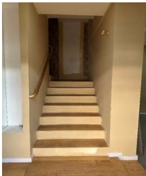
Foto 07 – Escada de acesso Andar Superior Sala1
