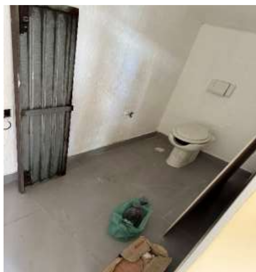
Foto 09 – Banheiro Piso Térreo Sala1
