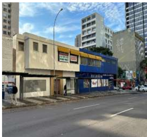
Foto 03 – Lateral do Imóvel voltado para a Avenida Marechal Floriano Peixoto
