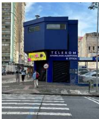
Foto 01 – Frente do Imóvel voltado para Marechal Deodoro
