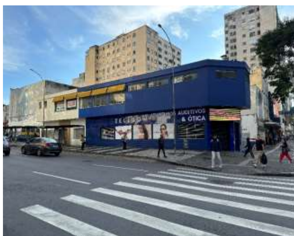
Foto 02 – Lateral do Imóvel voltado para a Avenida Marechal Floriano Peixoto
