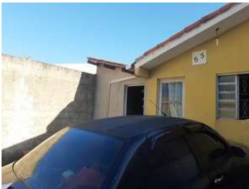
FOTO 21 – VISTA DA GARAGEM
