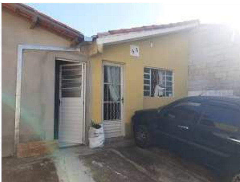
FOTO 21 – VISTA DA FACHADA
