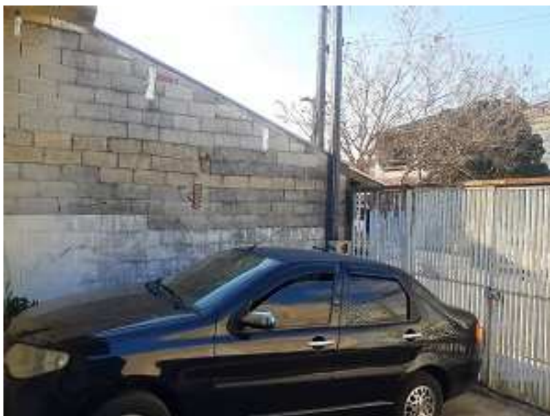
FOTO 22 – VISTA DO PORTÃO
