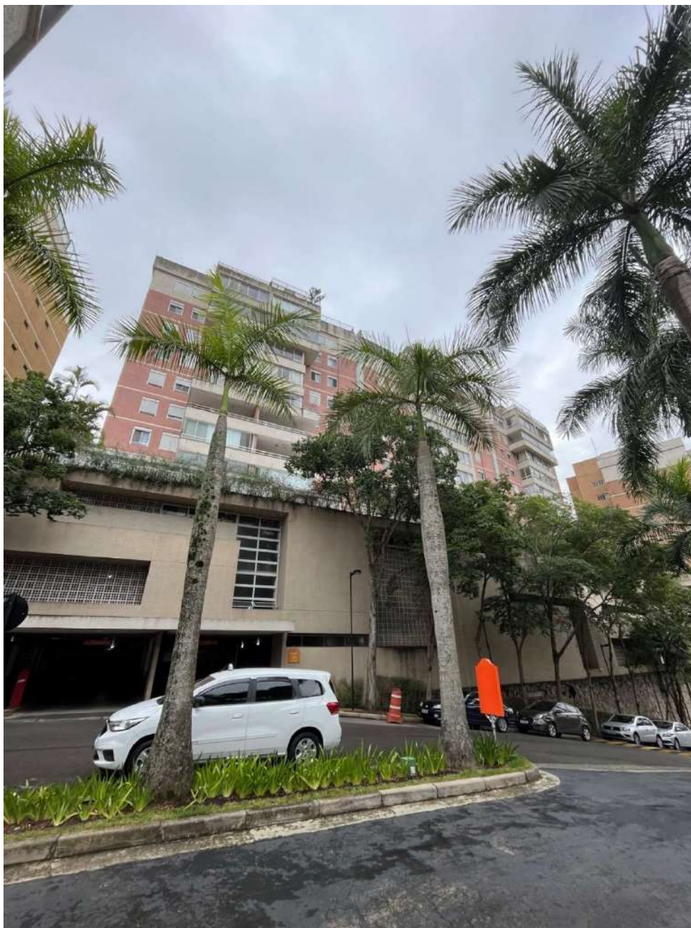
Figura 10: Edifício Salerno – garagem no subsolo
