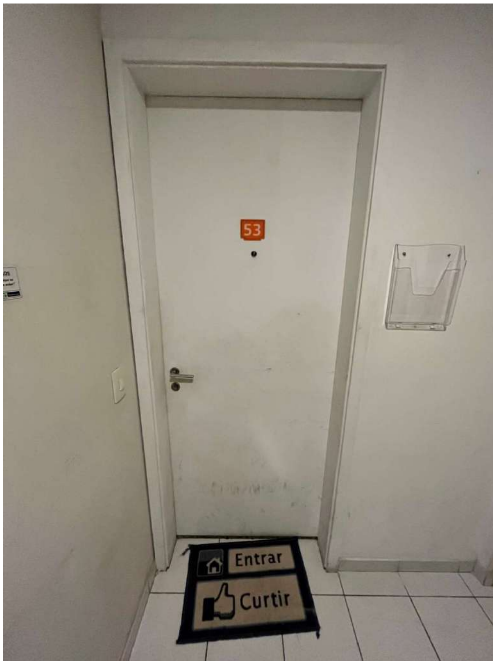
Figura 15: porta do Imóvel Avaliando - entrada de serviço
