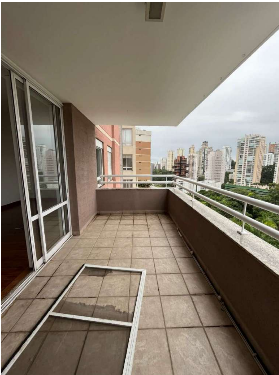
Figura 30: varanda - imóvel paradigma nº 42
