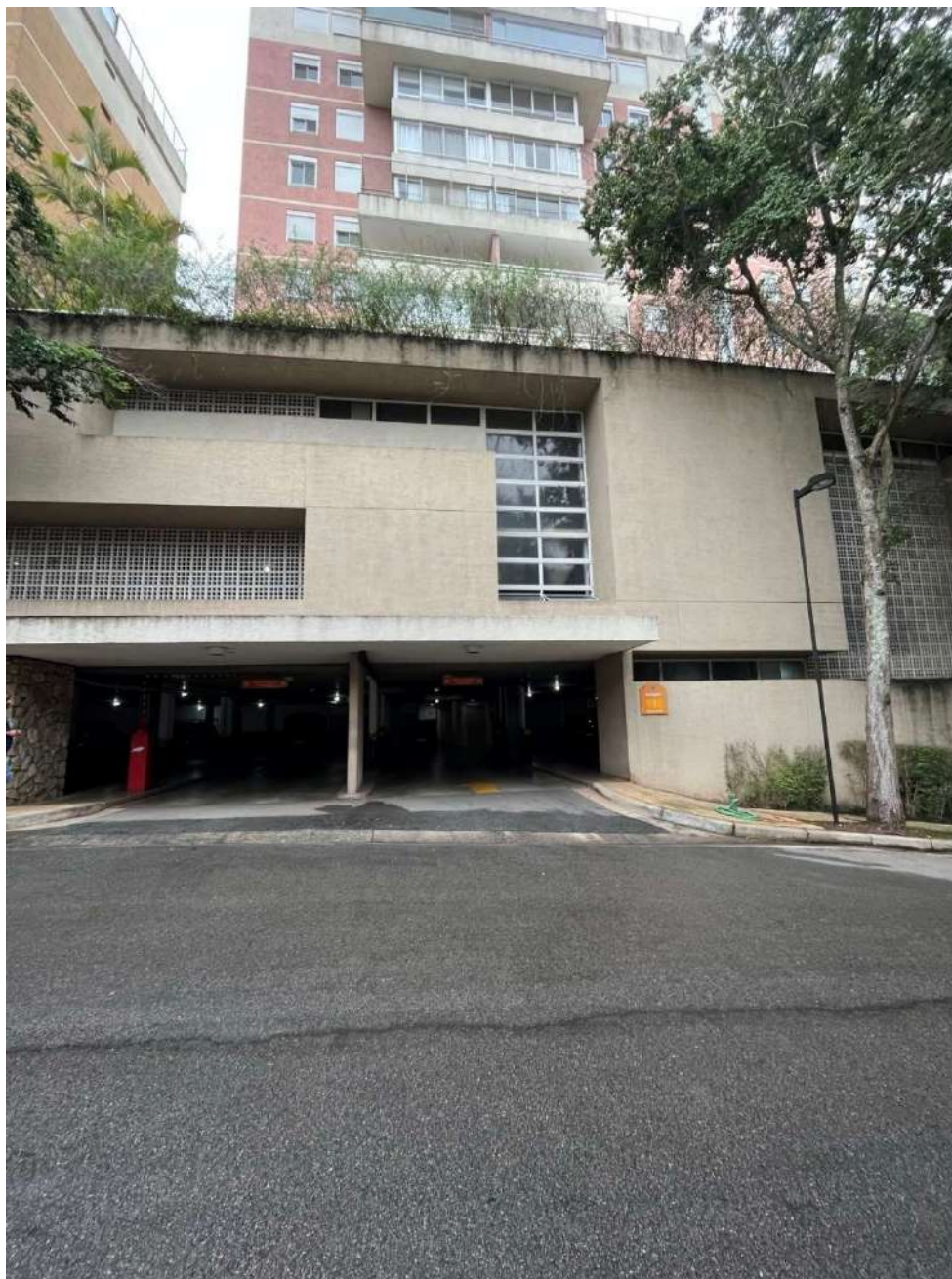
Figura 47: Edifício Salerno - vagas de garagem no subsolo
