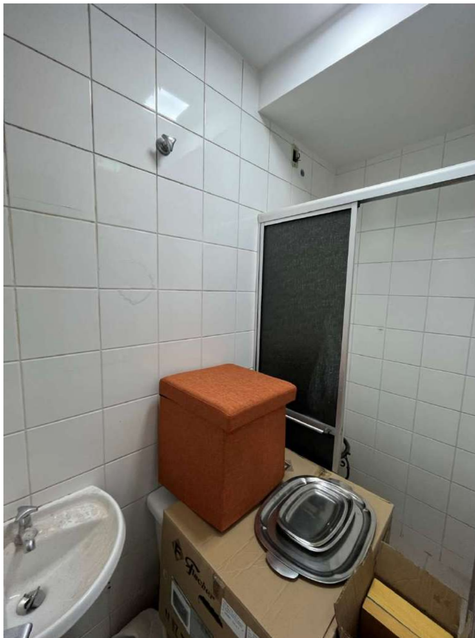
Figura 21: banheiro - área de serviço - imóvel paradigma nº 42
