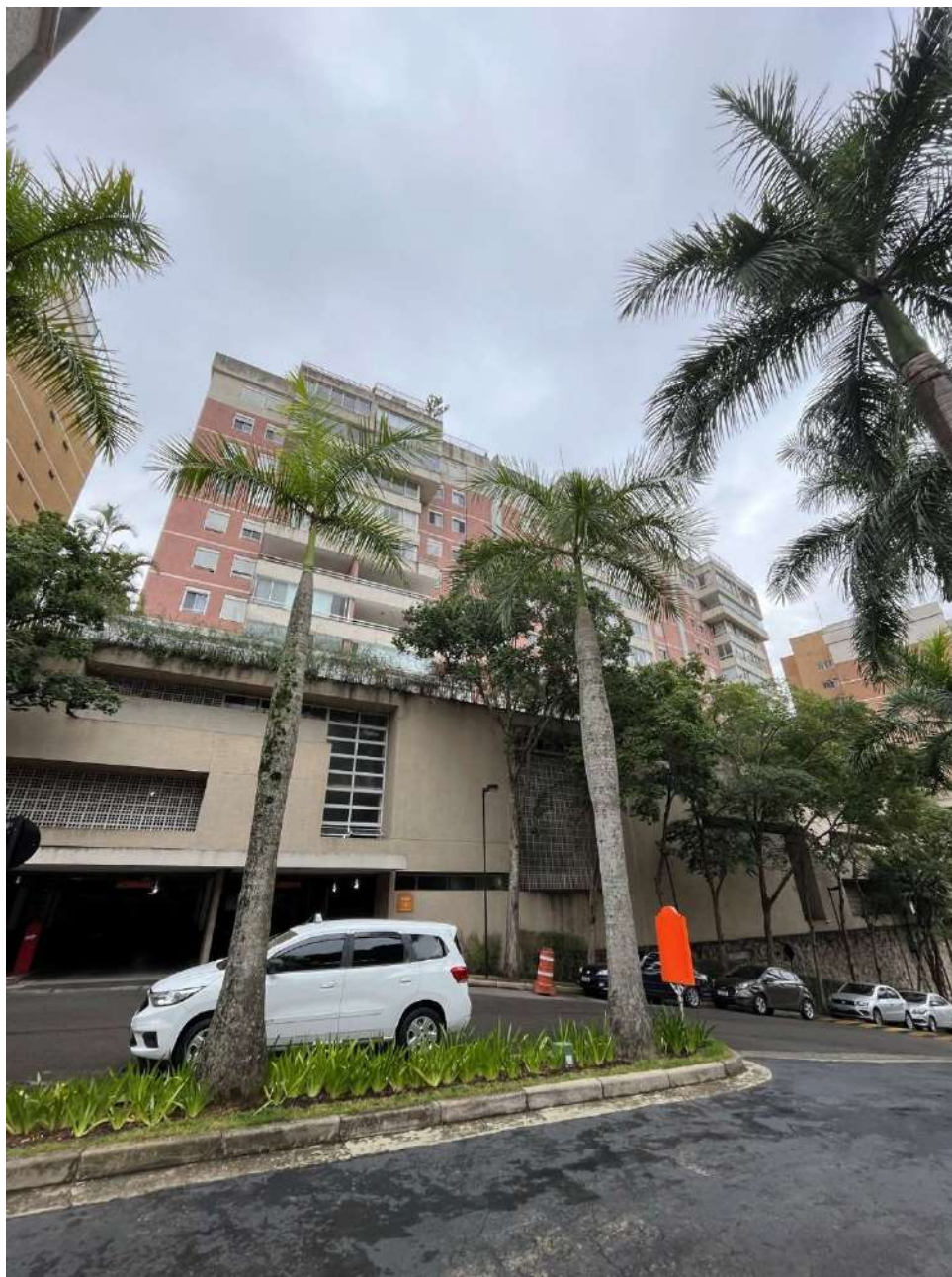
Figura 4: fachada da torre 08 – Ed. Salerno
