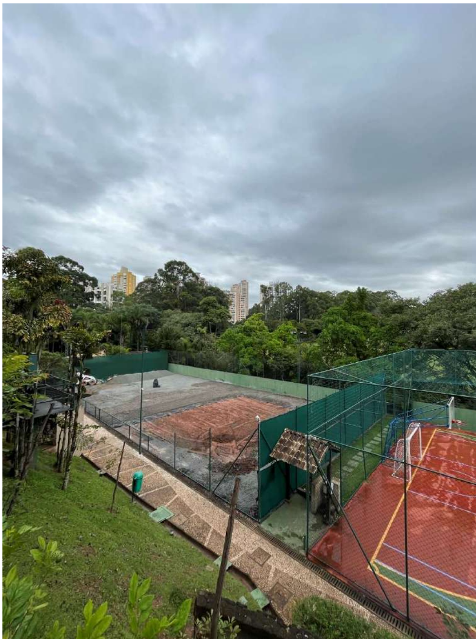
Figura 77: quadra de tênis em reforma e construção de quadra de beach tênis
