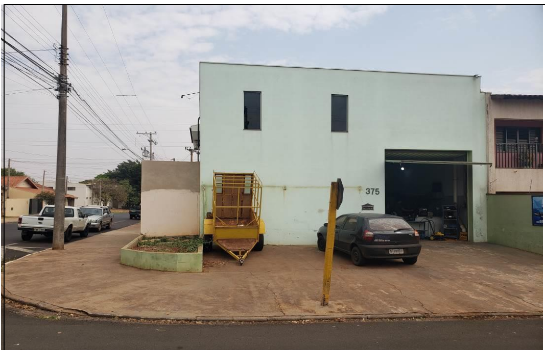
FOTO 01 – Vista frontal do imóvel avaliando.
