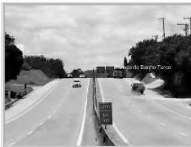
Foto nº 01 (A): A Rodovia Raposo Tavares (SP 270) possui condições de tráfego rápido e seguro em suas duas pistas de rolagem, que são separadas por muretas de alvenaria.
