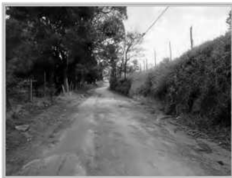
Foto nº 03 (0): Visão da Estrada do Banho Turco evidenciando as razoáveis condições de conservação do leito viário.
