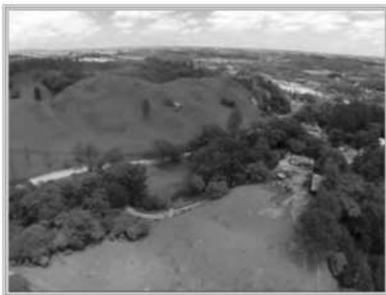
Foto nº 05 (📍): A propriedade é vislumbrada sob outra perspectiva com vistas para as benfeitorias em meio a dois filões de mata nativa.
