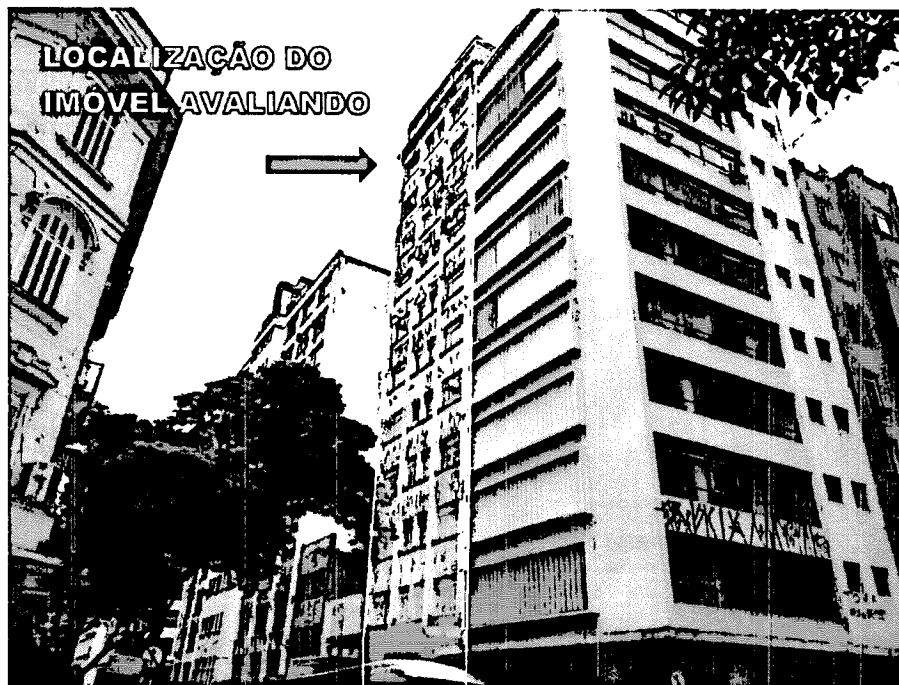
Figura 2 – Fachada do imóvel avaliando – Fonte: Autor
