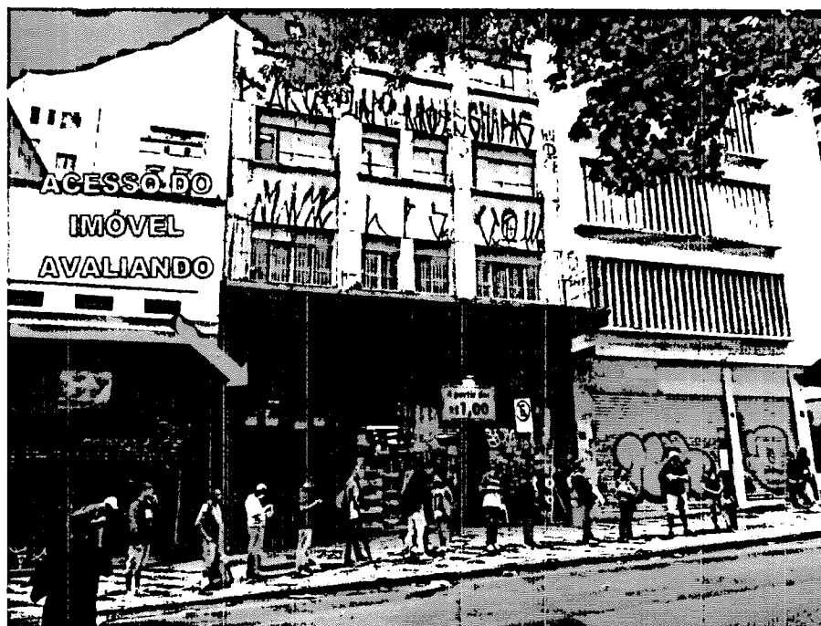
Figura 3 – Acesso ao Ed. Santa Rita – Fonte: Autor
