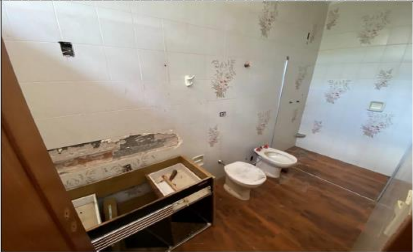
FOTO 06 – Vista geral de um dos banheiros do imóvel.
