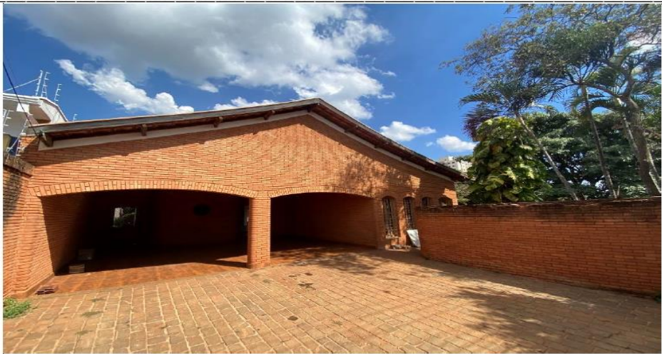
FOTO 02 – Vista geral frontal do imóvel avaliando.
