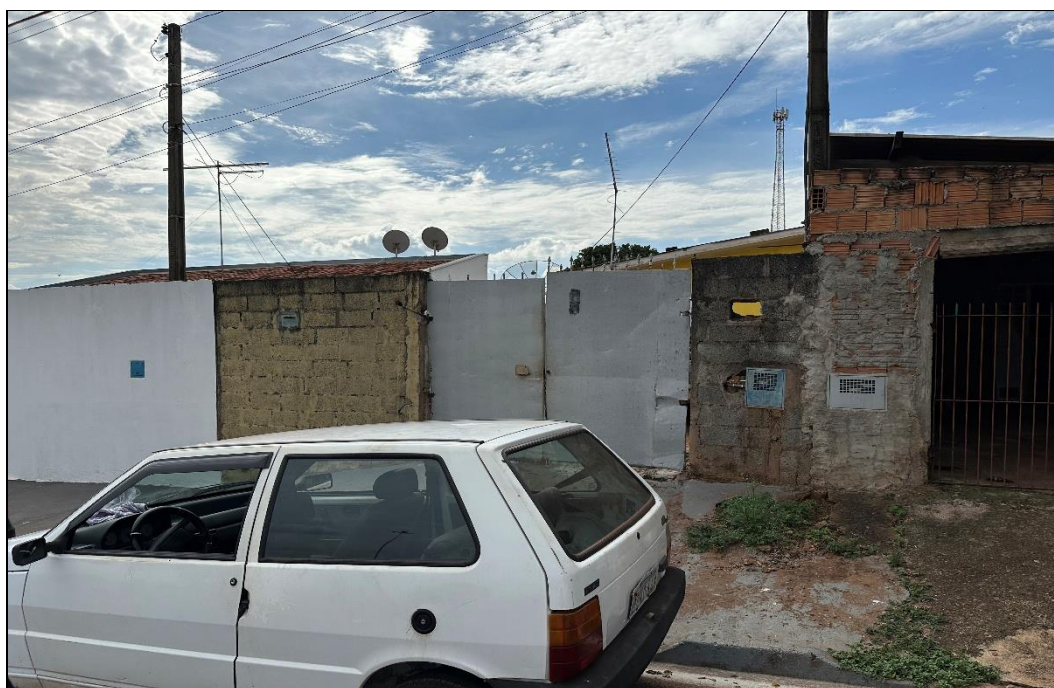
FOTO 01 – Vista frontal do imóvel pela Avenida Alberto Gomiero.
