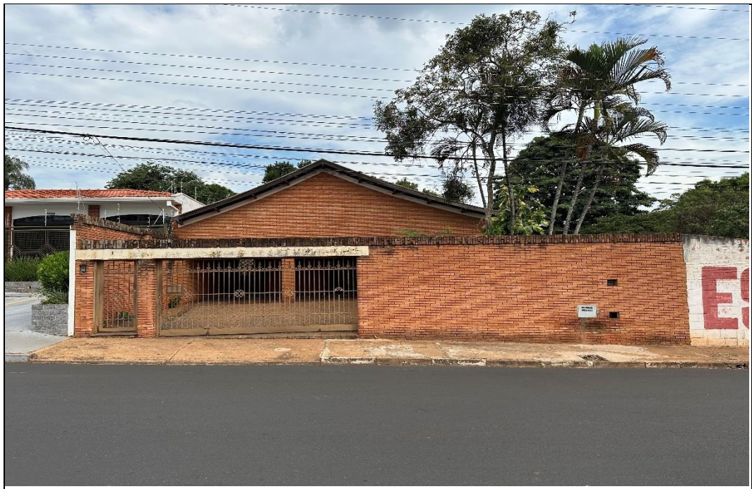
FOTO 01 – Vista geral frontal do imóvel vistoriado.
