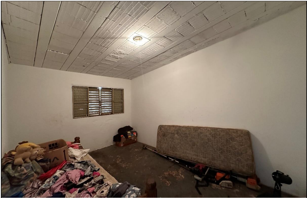
FOTO 05 – Vista geral do dormitório do imóvel.
