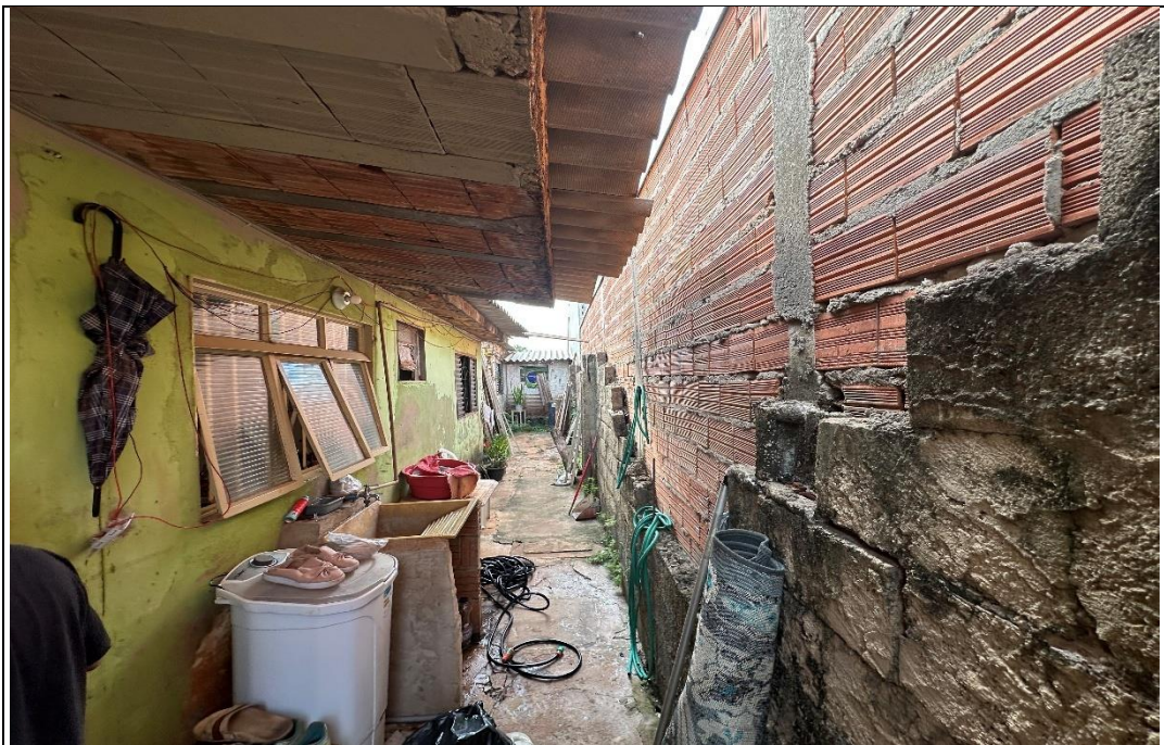
FOTO 10 – Vista do corredor lateral do imóvel.
