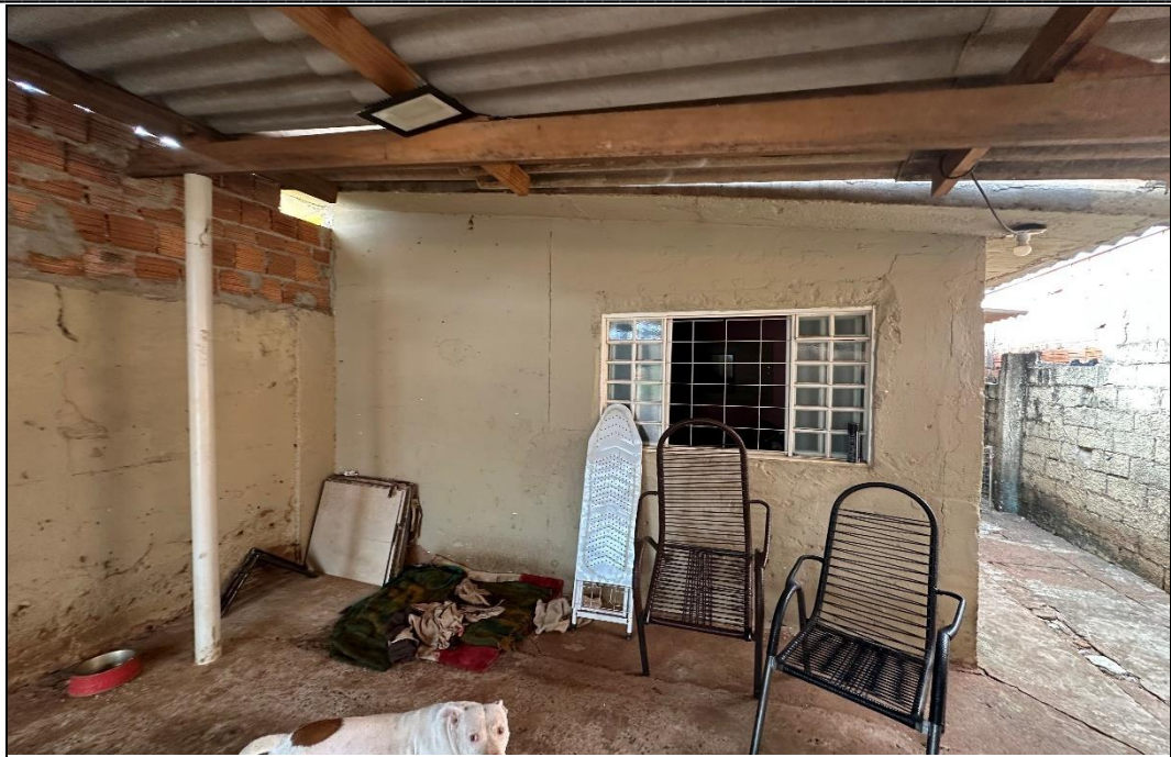
FOTO 09 – Vista frontal do imóvel e da garagem coberta.
