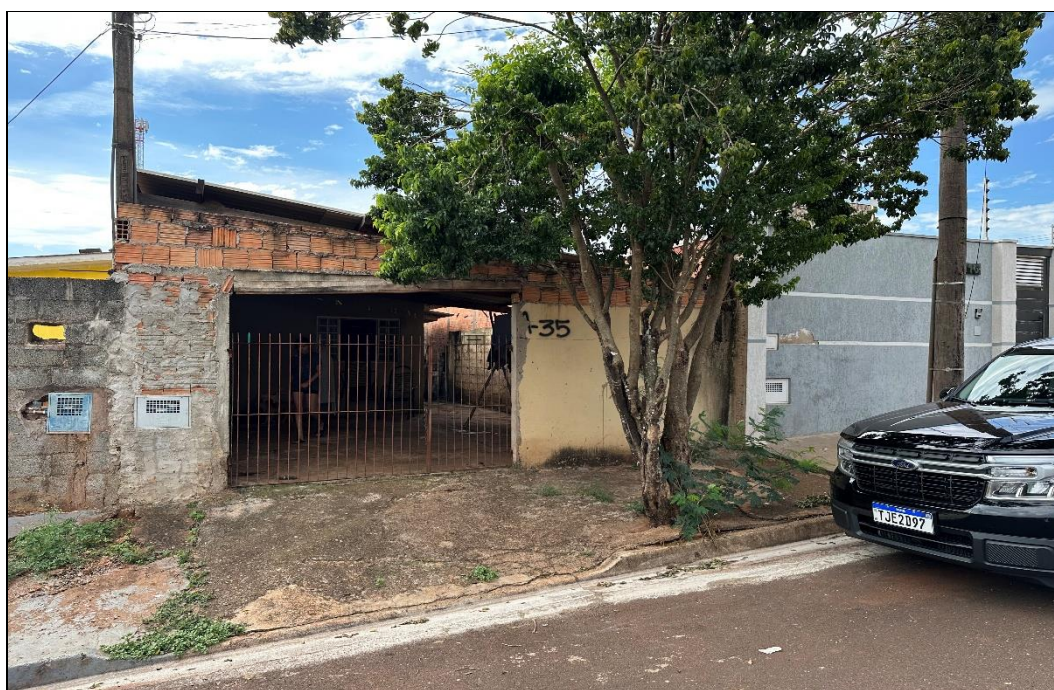
FOTO 08 – Vista frontal do imóvel pela Avenida Alberto Gomiero.
