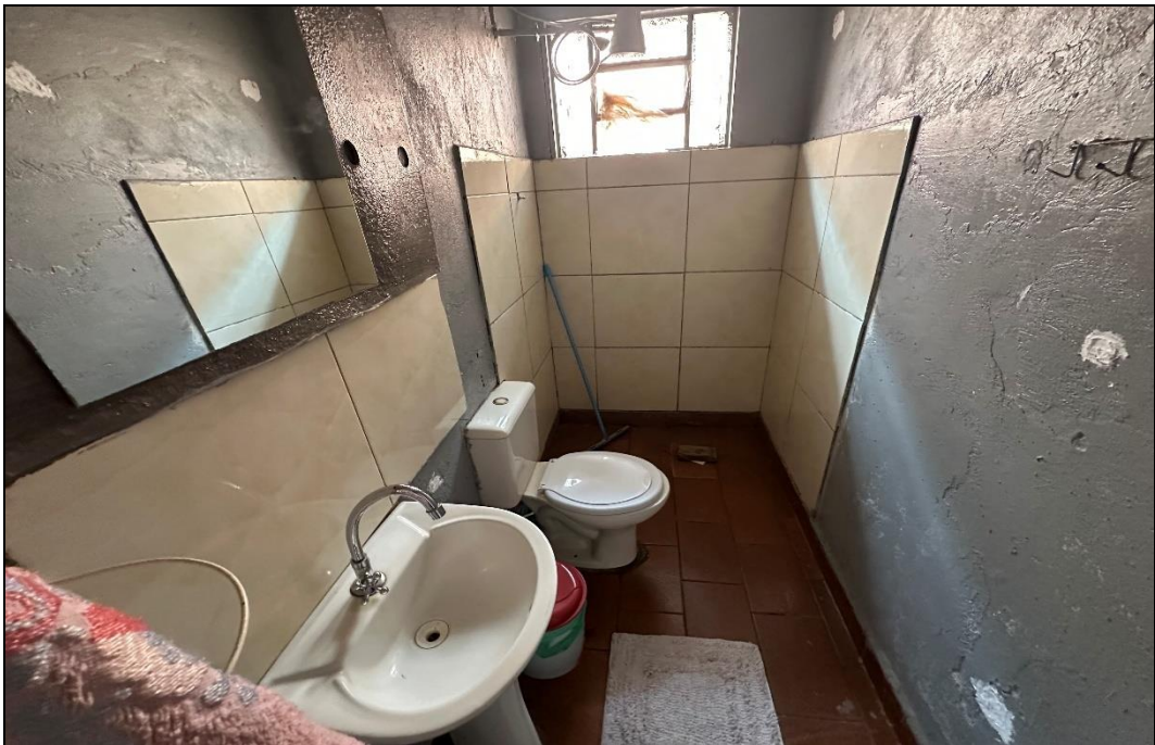
FOTO 14 – Vista geral do banheiro do imóvel.
