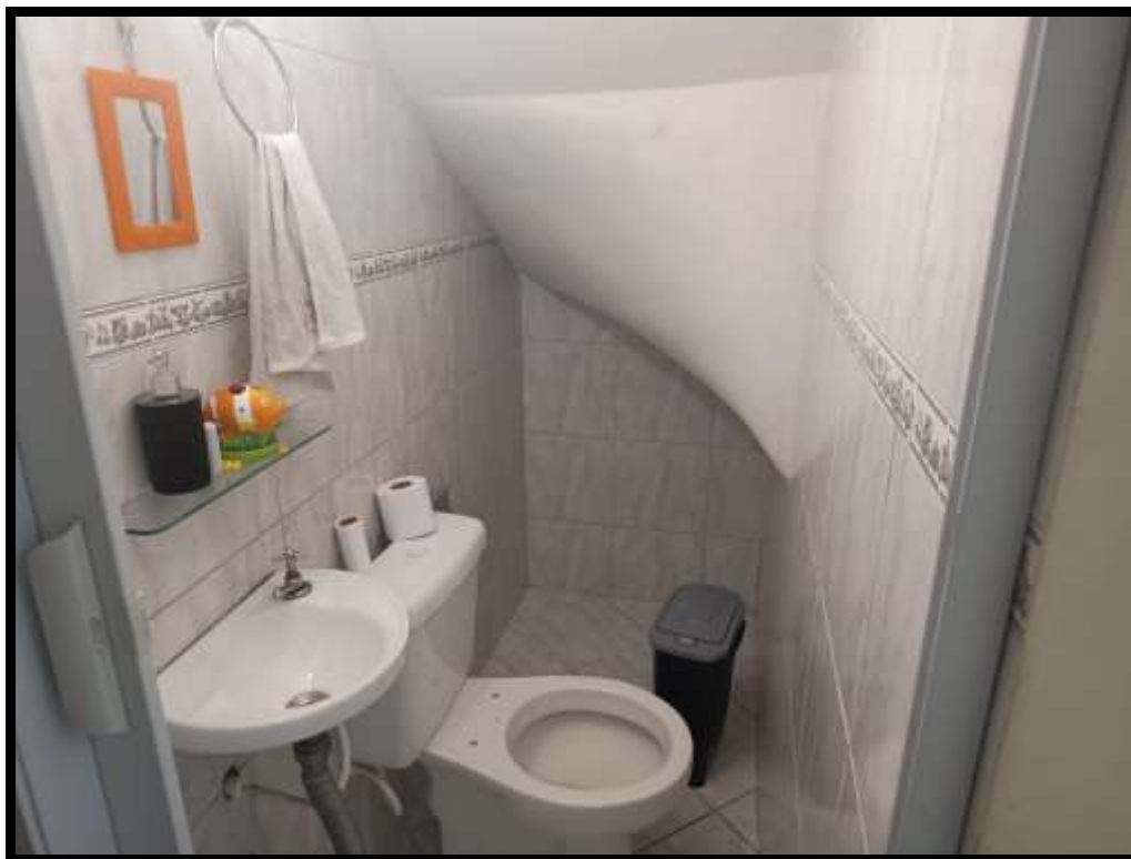
VISTA DO LAVABO, LOCALIZADO EMBAIXO DA ESCADA
