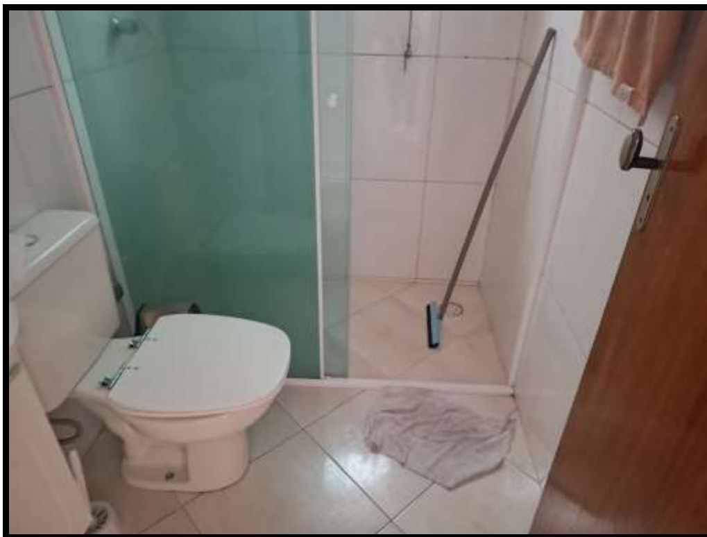
OUTRA VISTA DO BANHEIRO LOCALIZADO NO PAVIMENTO SUPERIOR.
