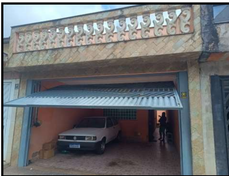
VISTA DA FACHADA DO IMÓVEL AVALIANDO
