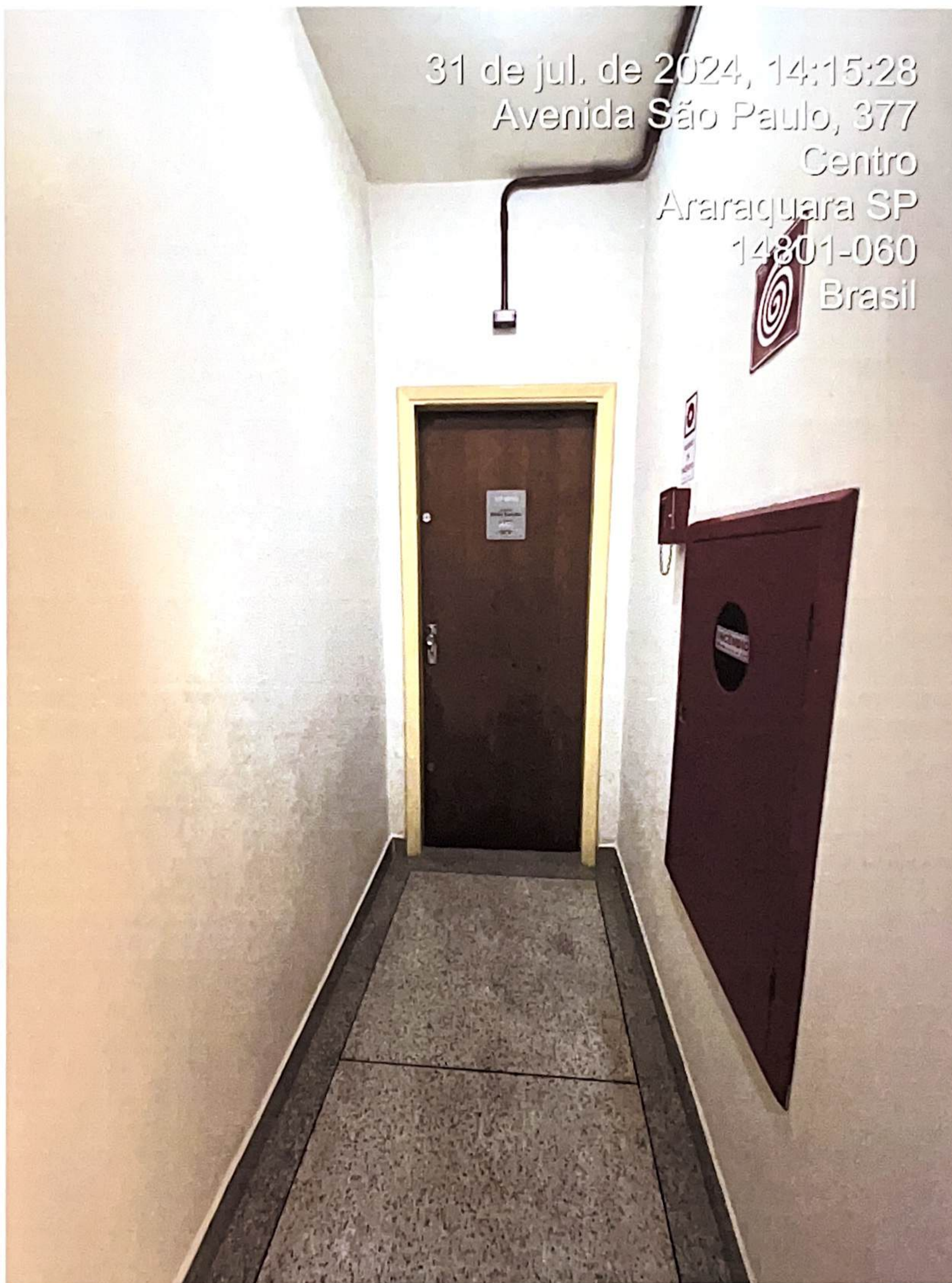
Foto 13 – Hall de acesso
