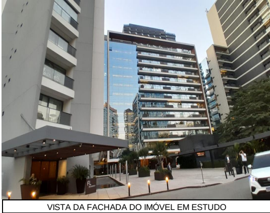
VISTA DA FACHADA DO IMÓVEL EM ESTUDO
