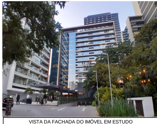
VISTA DA FACHADA DO IMÓVEL EM ESTUDO
