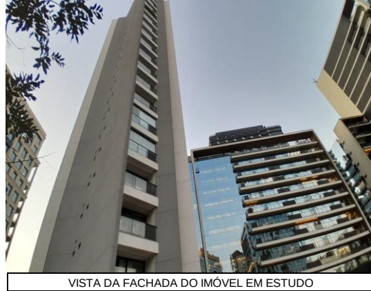
VISTA DA FACHADA DO IMÓVEL EM ESTUDO
