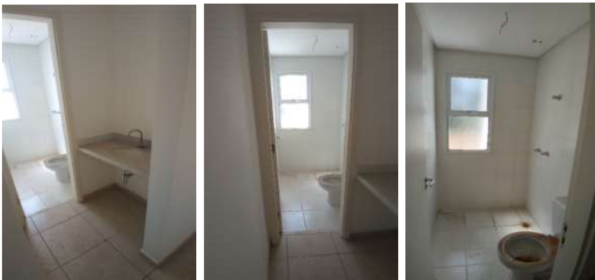
Fotos 13, 14 e 15 – Vista do sanitário.
