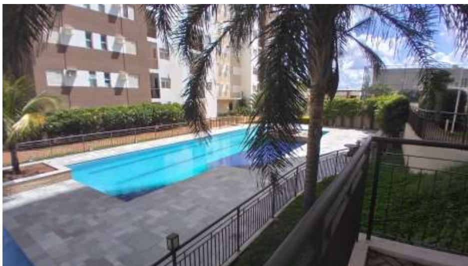
Foto 22 – Vista da piscina.
