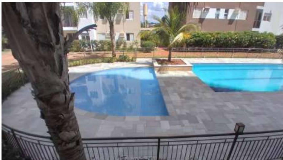
Foto 21 – Vista da piscina.
