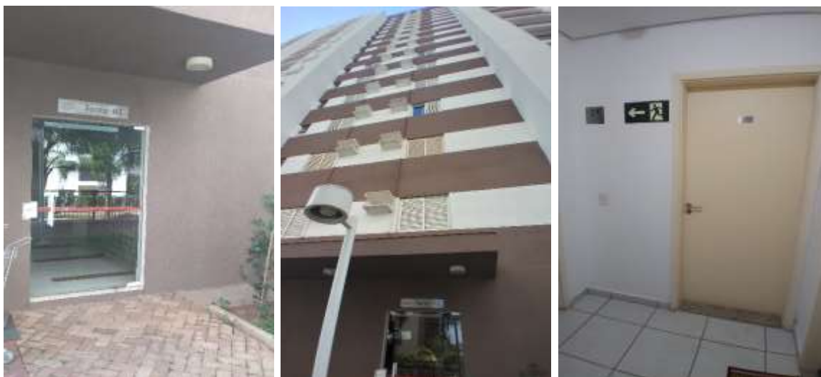
Fotos 02, 03 e 04 – Vista da Torre B1 e porta de acesso ao apartamento 14.
