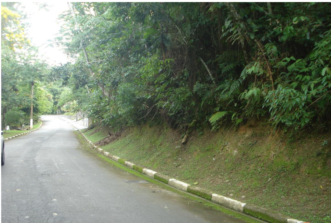
FOTO Nº 09 – Vista pela Avenida Yara à esquerda dos fundos do lote 04 da quadra 13 na Rua Tupy,
