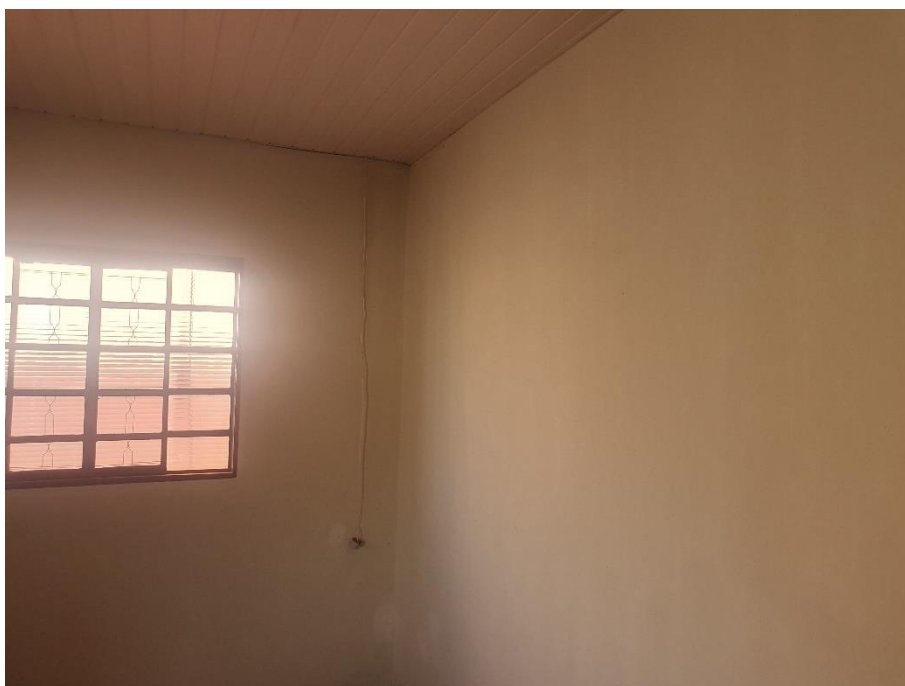
Foto 03/437 – Sala contendo piso cerâmico vermelho, paredes rebocadas e forro em pvc.
