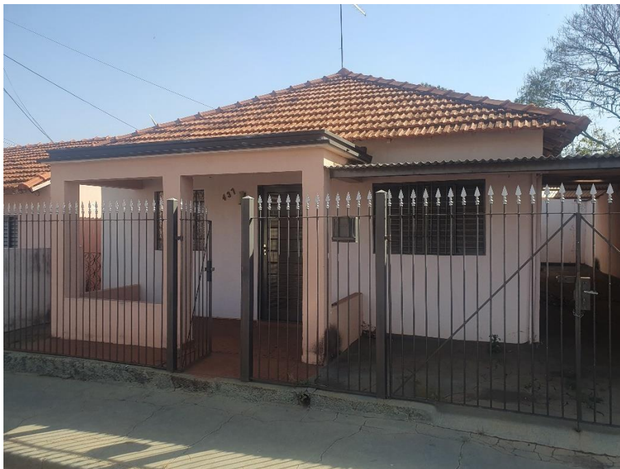
Foto 01/437 - Fachada Frontal contendo calçada publica pavimentada em concreto, com gradil metálico em boas condições, paredes com reboco pintadas em pintura látex, e gradis e esquadrias pintados em pintura grafite, portas e janelas metálicas com vedação em vidro, telhado em telha francesa sem sinais de selagem (depressões).
