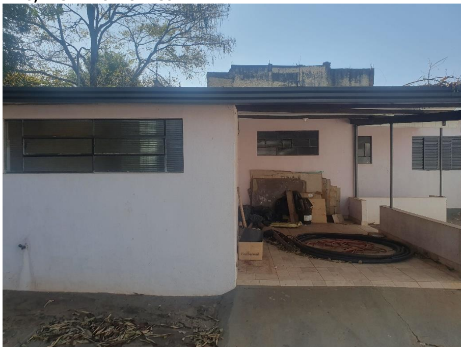
Foto 01/437 fundos – Fachada frontal demonstrando piso em concreto área com cobertura e calhas e rufos para captação pluvial, paredes rebocadas e portas e janelas metálicas com fechamento em vidro.
