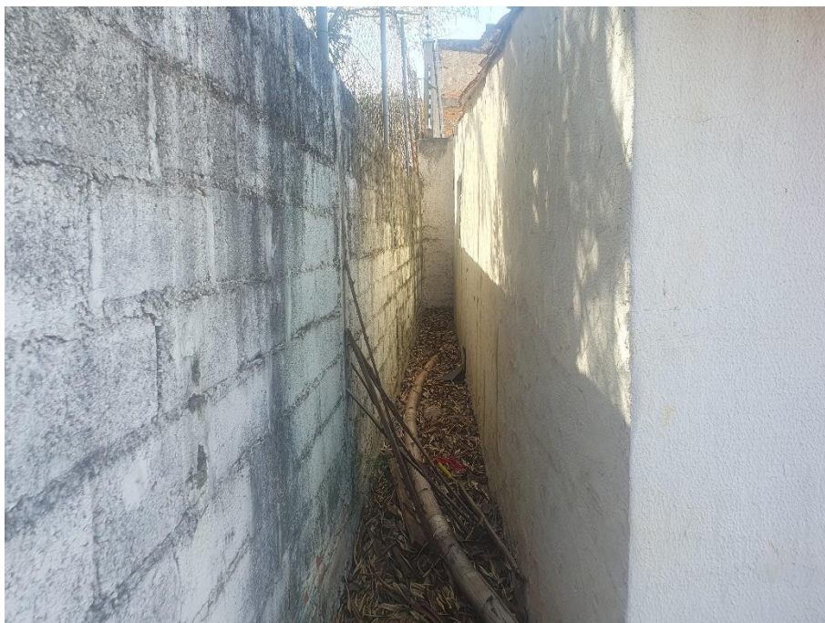
Foto 02/437 fundos – Corredor lateral da casa demonstrando piso em concreto, paredes rebocadas.
