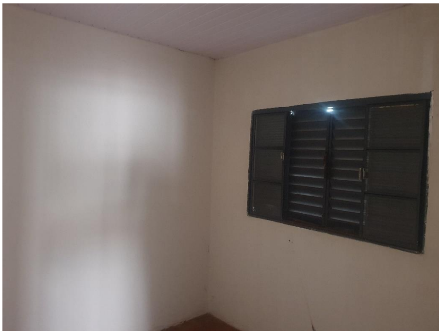
Foto 04/437 – Quarto 1 - contendo piso cerâmico vermelho, paredes rebocadas e forro em pvc.
