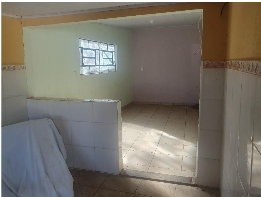
Foto 04/437 fundos – Cozinha Integrada com sala de estar , piso cerâmico, paredes rebocadas com revestimento em azulejo a meia altura, forro em pvc.
