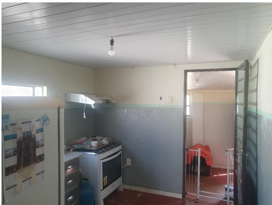
Foto 05/429 – Cozinha – Piso cimentado vermelho, paredes com reboco, forro em PVC, com pintura a óleo até a meia altura.
