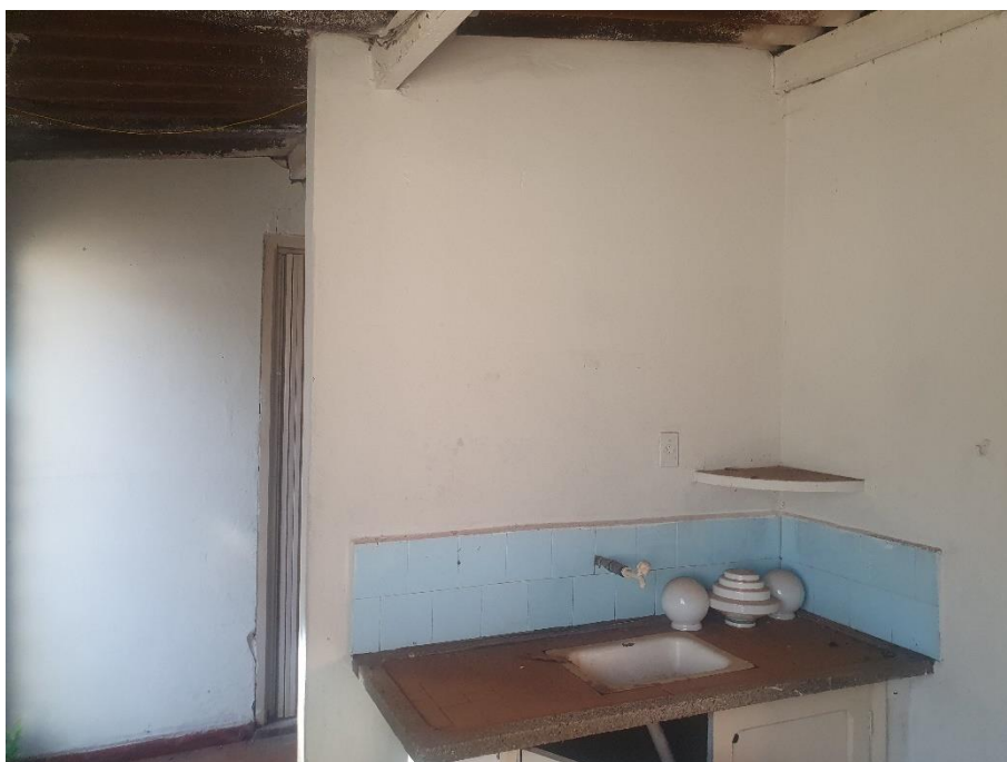
Foto 06/437 – Cozinha - contendo piso cerâmico vermelho, paredes rebocadas sem forro.
