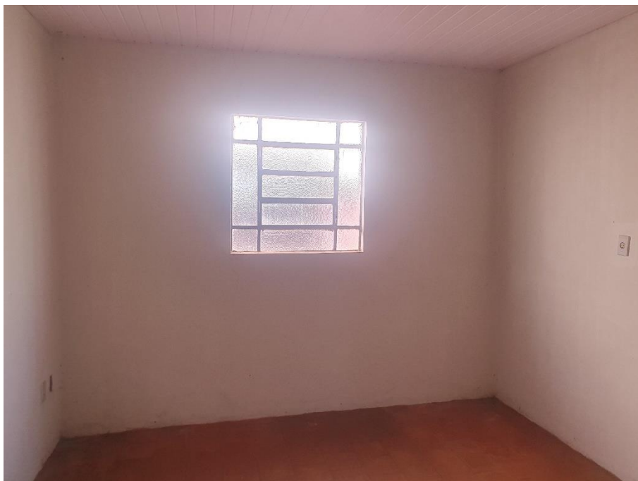
Foto 05/437 – Sala de Jantar - contendo piso cerâmico vermelho, paredes rebocadas e forro em pvc.
