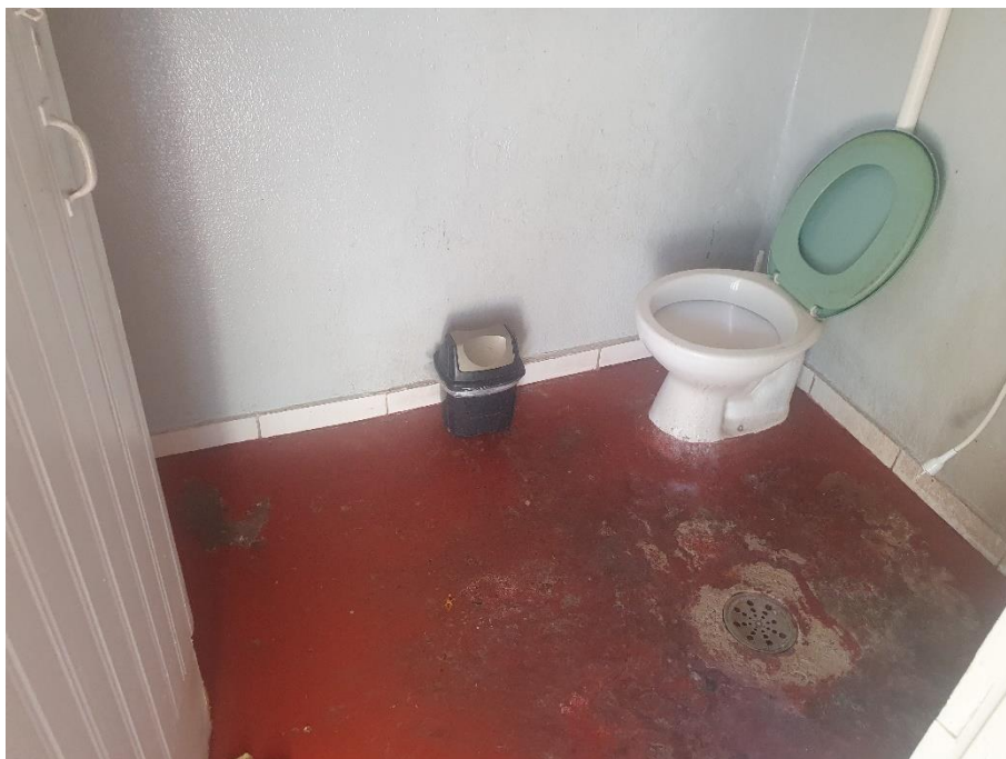
Foto 11/429 – Banheiro – Piso cimentado vermelhão, forro em pvc, com chuveiro, vaso e caixa de descarga.
