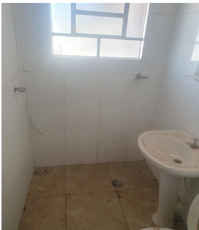
Foto 06/437 fundos – Banheiro, piso cerâmico, paredes em azulejo até o forro, forro em pvc.
