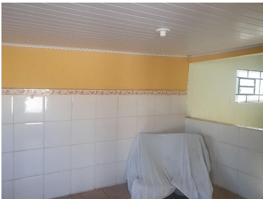
Foto 03/437 fundos – Cozinha Integrada com sala de estar, piso cerâmico, paredes rebocadas com revestimento em azulejo a meia altura, forro em pvc.
