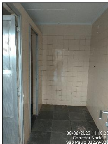
Foto 40. Vista do banheiro social condomínio
