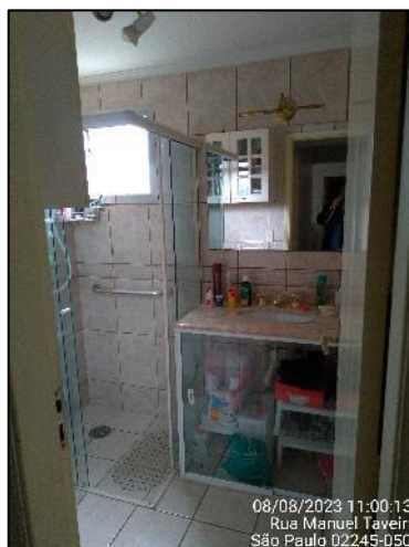
Foto 1. Vista do banheiro
