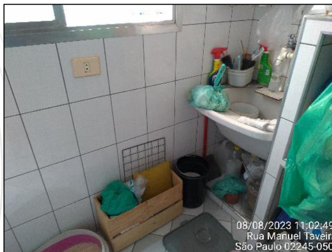
Foto 18. Vista da área de serviço
