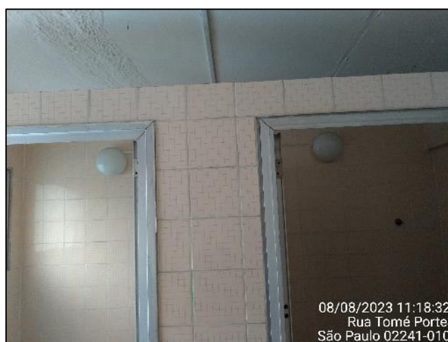
Foto 41. Vista do banheiro social condomínio
