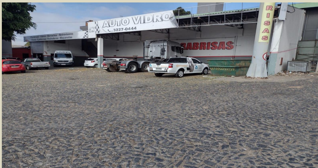
Vista do Barracão em aberto
