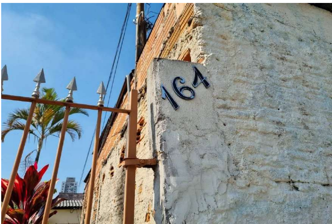
FOTO 2 – Vista do número aparente no imóvel situado aos fundos dos lotes.
