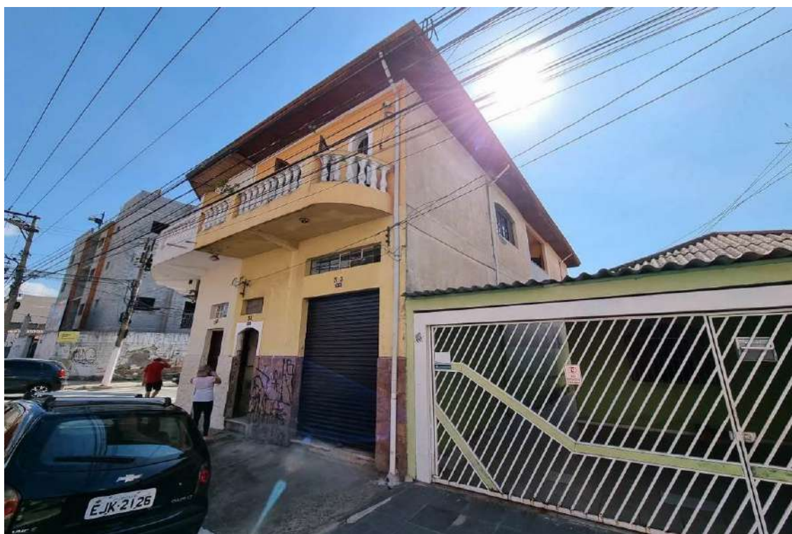
FOTO 61 - Vista externa do imóvel nº 347 e 816, no primeiro andar do sobrado erigido sobre a esquina do Lote 38. Apresentando padrões construtivos de alvenarias com pintura látex PVA sobre massa, telhado cerâmico e esquadrias de madeira.
