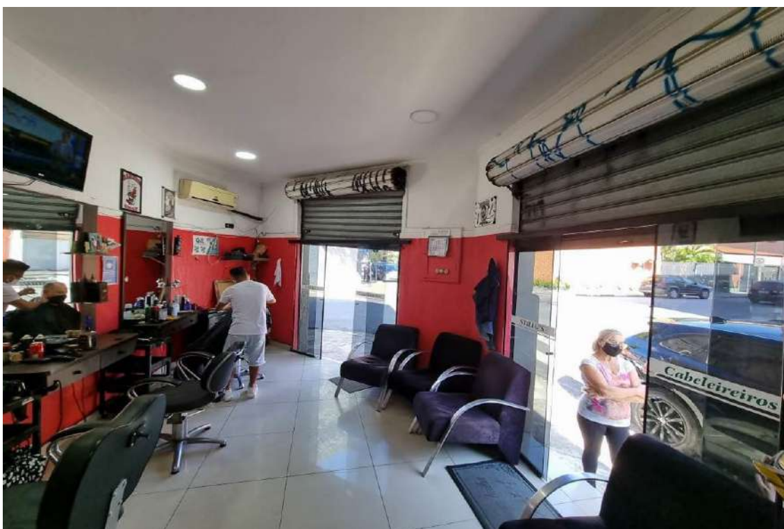
FOTO 42 – Vista interna do salão da loja da esquina nº 335. Apresentando padrões construtivos de piso cerâmico, alvenarias com pintura látex PVA sobre massa texturizada em meia parede, teto com forro de gesso e portas de aço.
