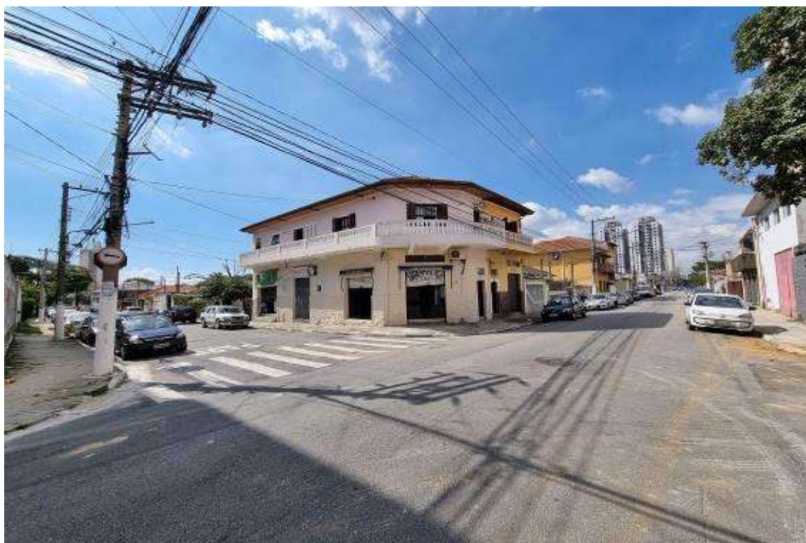
FOTO 1 – Vista dos imóveis erigidos sobre parte dos Lotes 36 e 38 da quadra 018.
