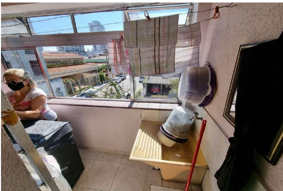
FOTO 54 - Vista da área de serviço do imóvel nº 341 e 818. Apresentando padrões construtivos de piso cerâmico, alvenarias com pintura látex PVA sobre massa texturizada, teto com pintura sobre laje, portas de madeira e janela de alumínio.
