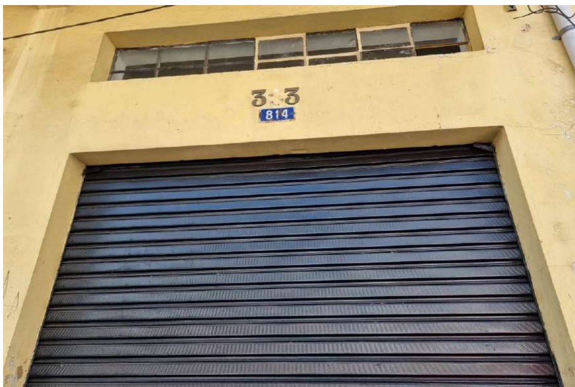
FOTO 56 - Vista da loja inserida no pavimento térreo do sobrado erigido sobre a esquina do Lote 38, nº 353 e 814.
