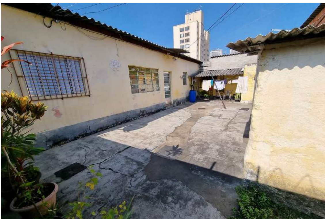
FOTO 6 – Vista da casa nº 164, erigida sobre os fundos dos lotes 36 e 38. Apresentando padrões construtivos de piso externo cimentado, alvenarias externas revestidas em pintura látex PVA sobre massa, telhas de fibrocimento, esquadrias em alumínio.
