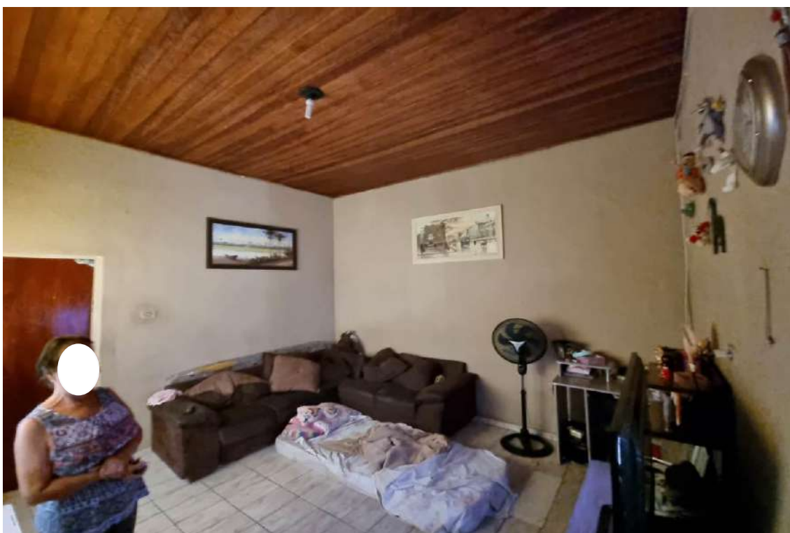
FOTO 12 - Vista da sala de estar do imóvel nº 164. Apresentando padrões construtivos de piso cerâmico, alvenarias revestidas em pintura látex PVA sobre massa, telhas de fibrocimento com forro de madeira, esquadrias em alumínio e porta de madeira.
