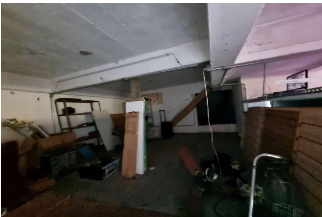
FOTO 39 – Vista do mezanino da loja nº 152. Apresentando padrões construtivos de piso de madeira, alvenarias com pintura látex PVA sobre massa, teto com pintura látex e porta de aço.
