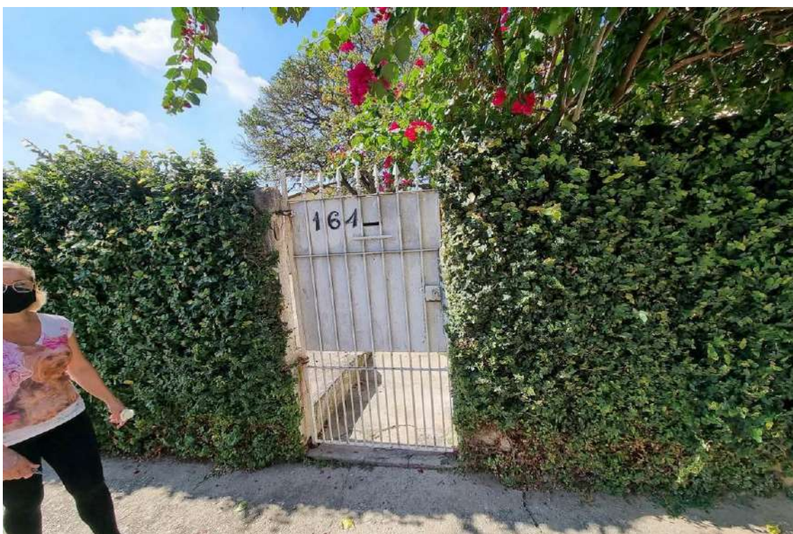
FOTO 23 - Vista parcial da fachada do terreno de garagem nº 164, situado no meio do Lote 38.
