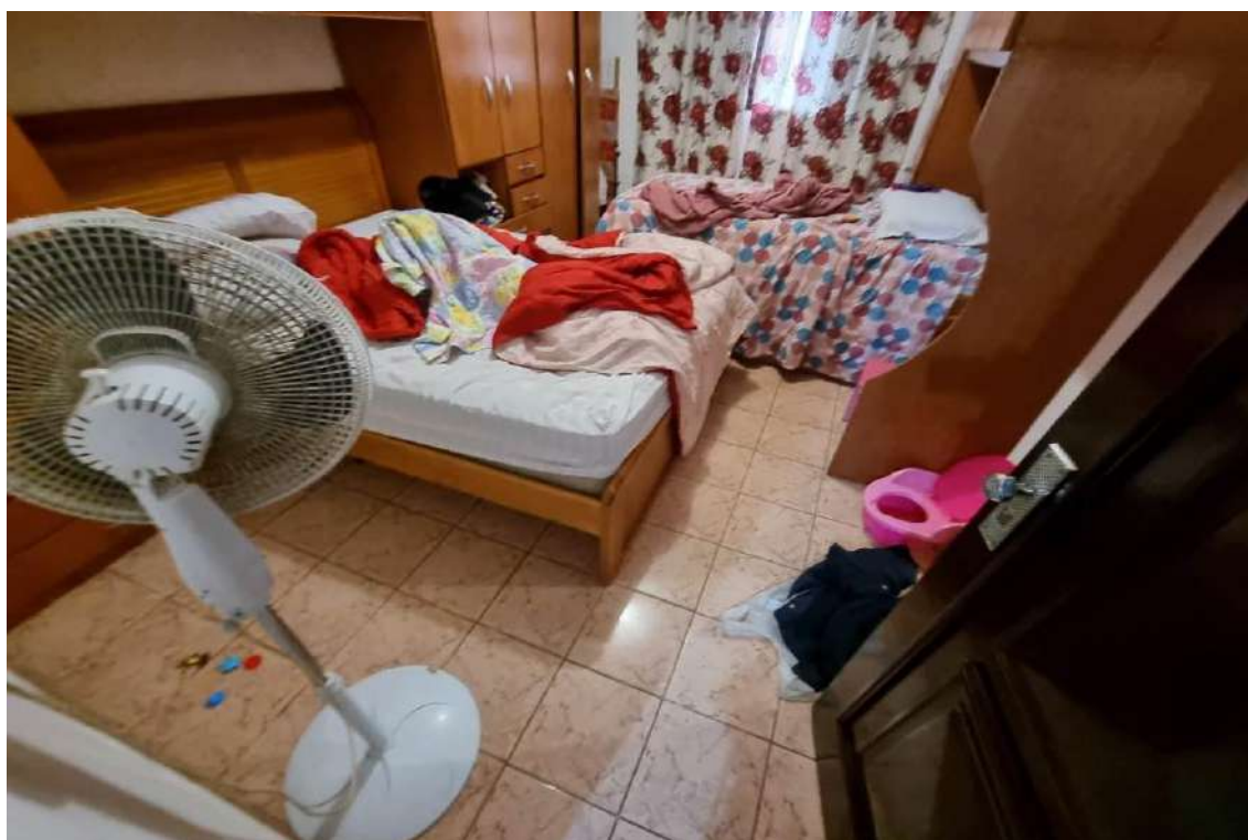
FOTO 77 - Vista do dormitório I do imóvel. Apresentando padrões construtivos de piso cerâmico, alvenarias com pintura látex PVA sobre massa, forro de madeira e esquadrias em madeira.
