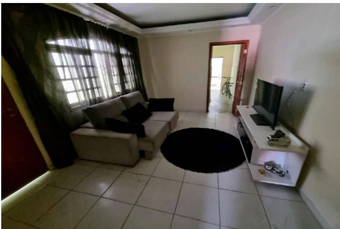
FOTO 71 - Vista da sala de estar do imóvel nº 357 e 810. Apresentando padrões construtivos de piso cerâmico, alvenarias com pintura látex sobre massa corrida, forro de gesso, esquadrias em madeira.
