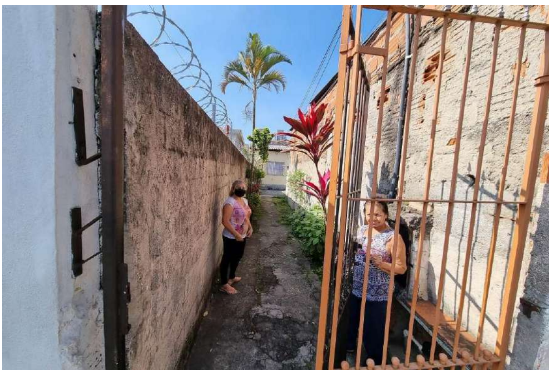
FOTO 3 – Vista do corredor de acesso ao imóvel de nº 164, aos fundos dos Lotes 36 e 38. Apresentando padrões construtivos de piso externo cimentado, alvenarias externas parcialmente revestidas em chapisco e outras partes com bloco aparente.
