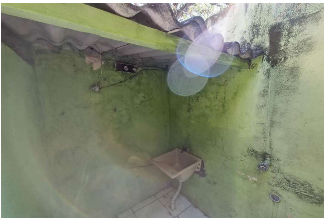
FOTO 66 - Vista da área de serviço no recuo lateral esquerdo do imóvel nº 357 e 810. Apresentando padrões construtivos de piso cerâmico, alvenarias com pintura látex PVA sobre massa, telhado de fibrocimento.
