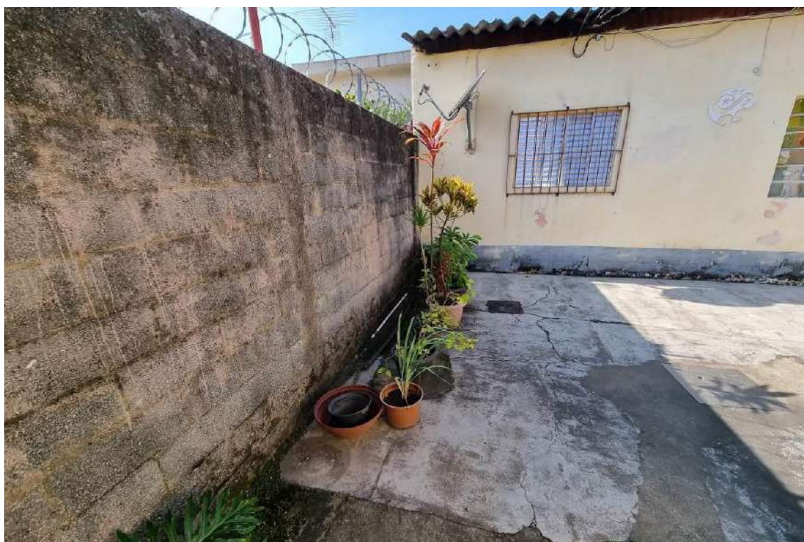
FOTO 5 - Vista do muro de divisa de fundos dos Lotes 36 e 38.
