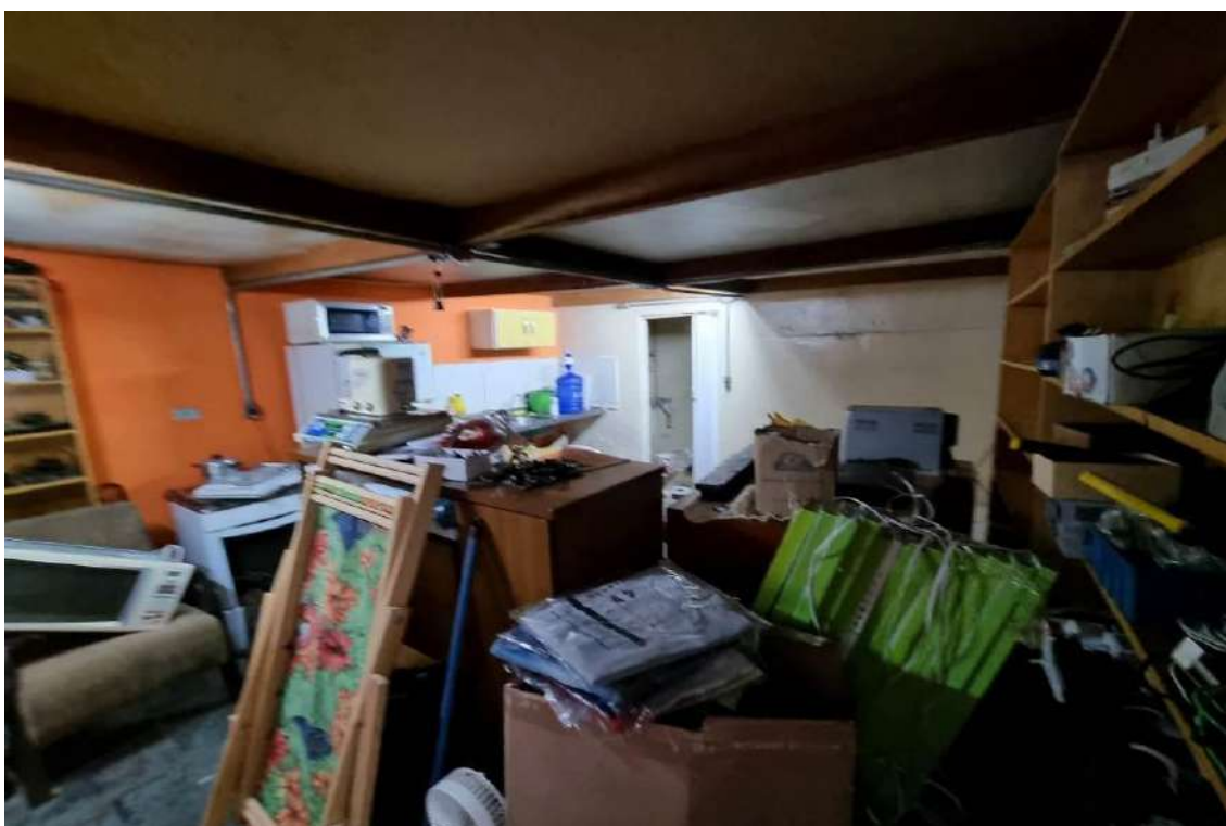
FOTO 38 – Vista do depósito da loja nº 152. Apresentando padrões construtivos de piso cimentado, alvenarias com pintura látex PVA sobre massa, teto com estrutura em madeira e fechamento em madeira.
