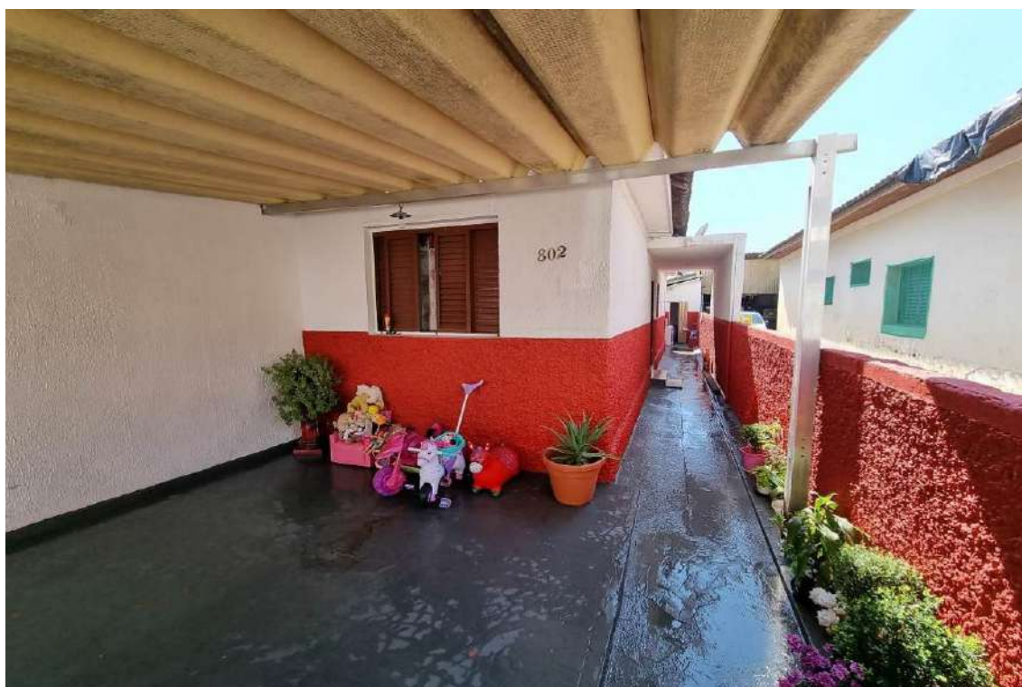
FOTO 74 - Vista da garagem do imóvel nº 802. Apresentando padrões construtivos de piso cimentado com pintura látex PVA, alvenarias com pintura látex PVA sobre massa, telhado de fibrocimento, esquadrias de madeira e portão em alumínio.
