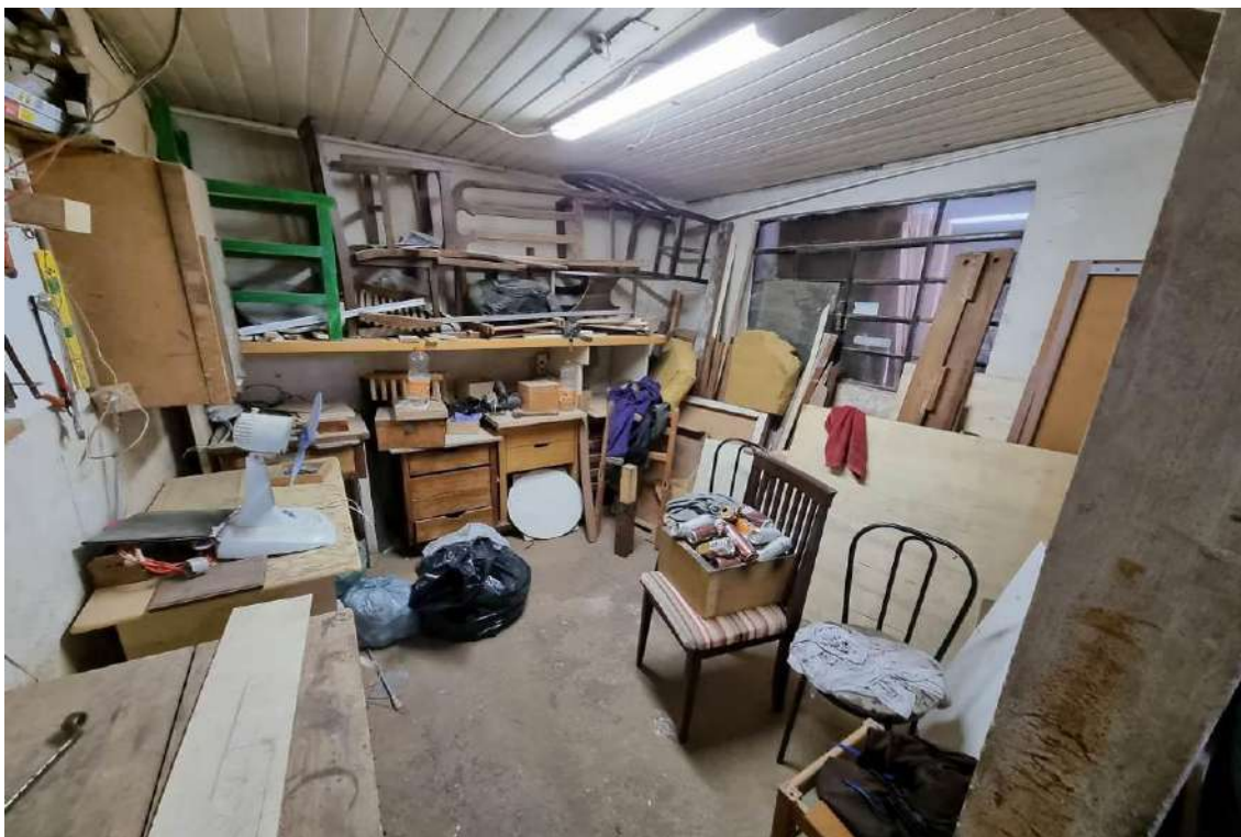
FOTO 18 - Vista interna do depósito II do imóvel nº 168. Apresentando padrões construtivos de piso cimentado, alvenarias revestidas em pintura látex PVA sobre massa, forro de madeira, esquadrias em aço e portas de madeira.
