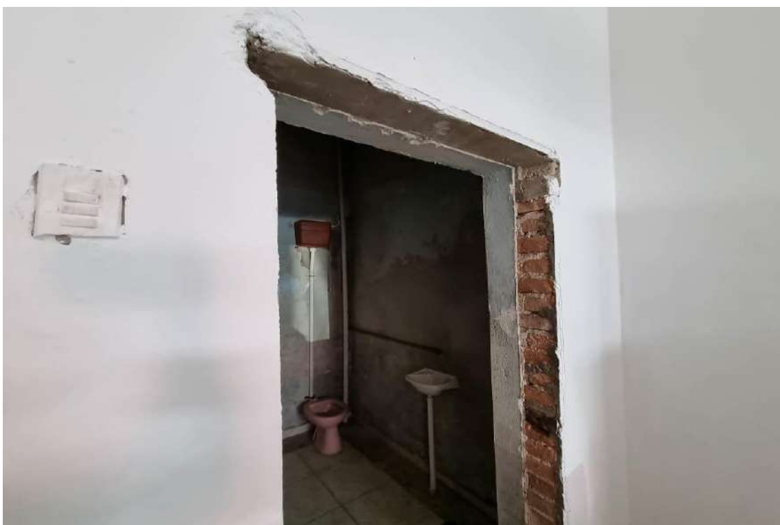
FOTO 58 – Vista do acesso ao banheiro da loja numeração 353 e 814.
