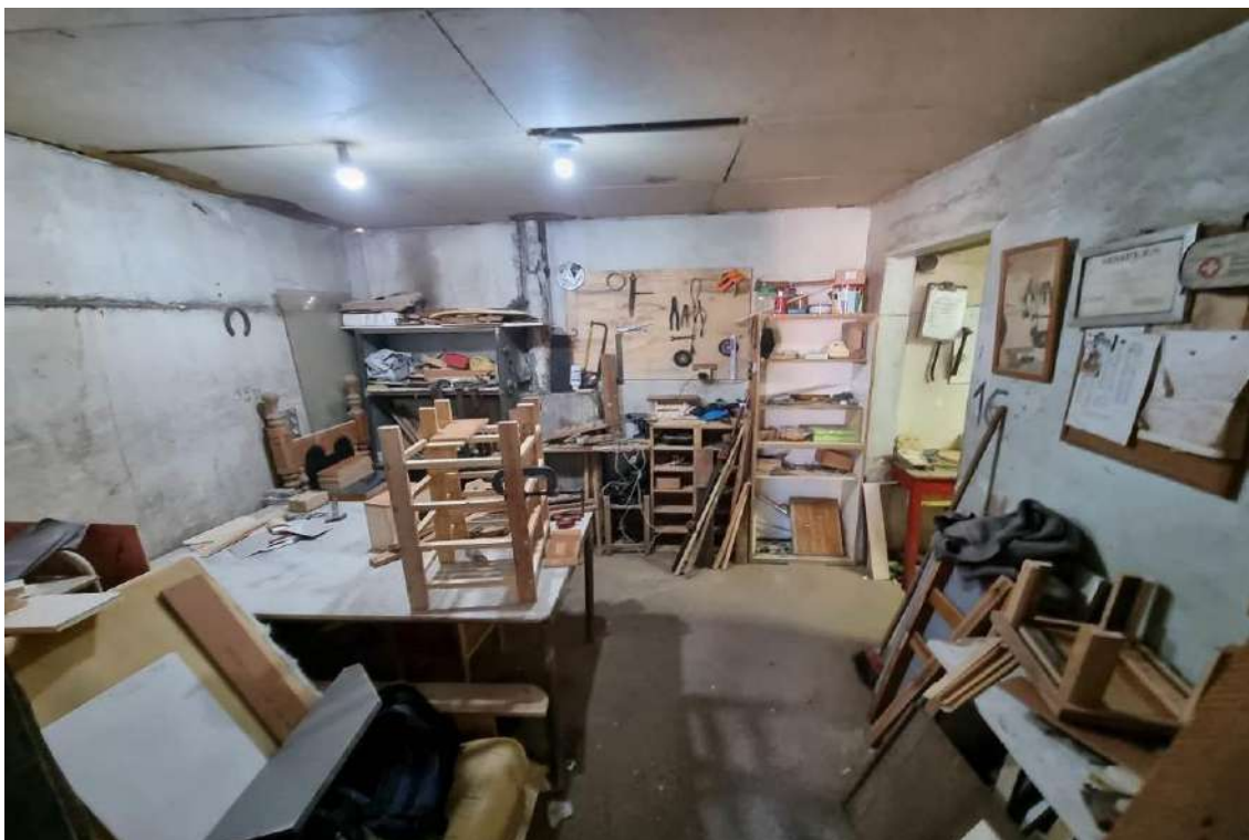
FOTO 17 - Vista interna do depósito I do imóvel nº 168. Apresentando padrões construtivos de piso cimentado, alvenarias revestidas em pintura látex PVA sobre massa, forro de madeira, esquadrias em aço e portas de madeira.
