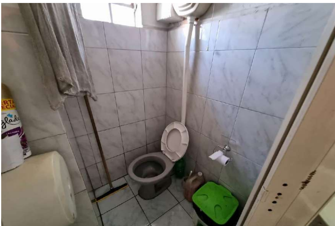
FOTO 45 - Vista do banheiro da loja. Apresentando padrões construtivos de piso cerâmico, alvenarias com revestimento cerâmico em meia parede e teto com forro de PVC.
