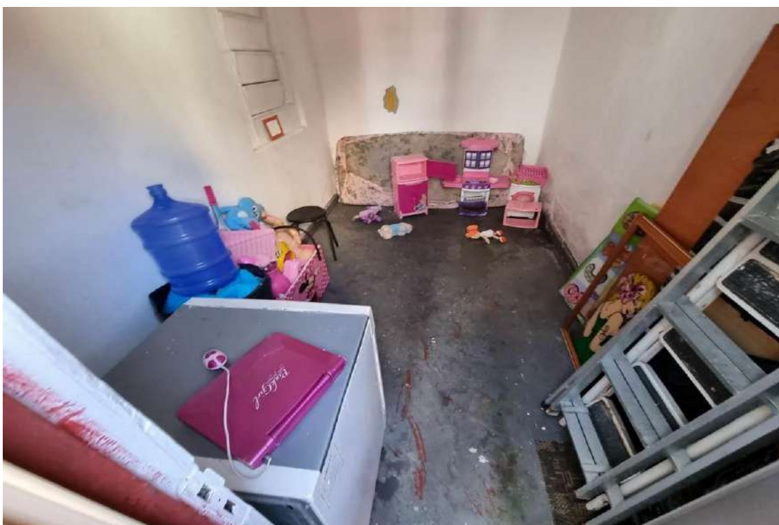
FOTO 81 - Vista da área de serviço. Apresentando padrões construtivos de piso cimentado, alvenarias com pintura látex PVA sobre massa, forro de madeira e porta em PVC sanfonado.
