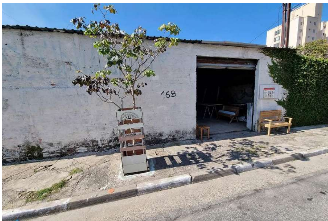
FOTO 14 – Vista do imóvel nº 168, erigido sobre parte do Lote 38. Apresentando fachada com pintura látex sobre chapisco.
