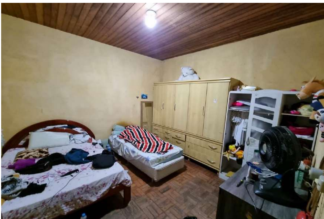
FOTO 13 - Vista do dormitório do imóvel nº 164. Apresentando padrões construtivos de piso cerâmico, alvenarias revestidas em pintura látex PVA sobre massa, telhas de fibrocimento com forro de madeira, esquadrias em alumínio e porta de madeira.
