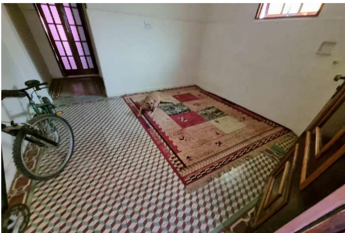
FOTO 69 - Vista da sala de jantar do imóvel nº 357 e 810. Apresentando padrões construtivos de piso cerâmico, alvenarias com pintura látex sobre massa corrida, forro de gesso, esquadrias em madeira.
