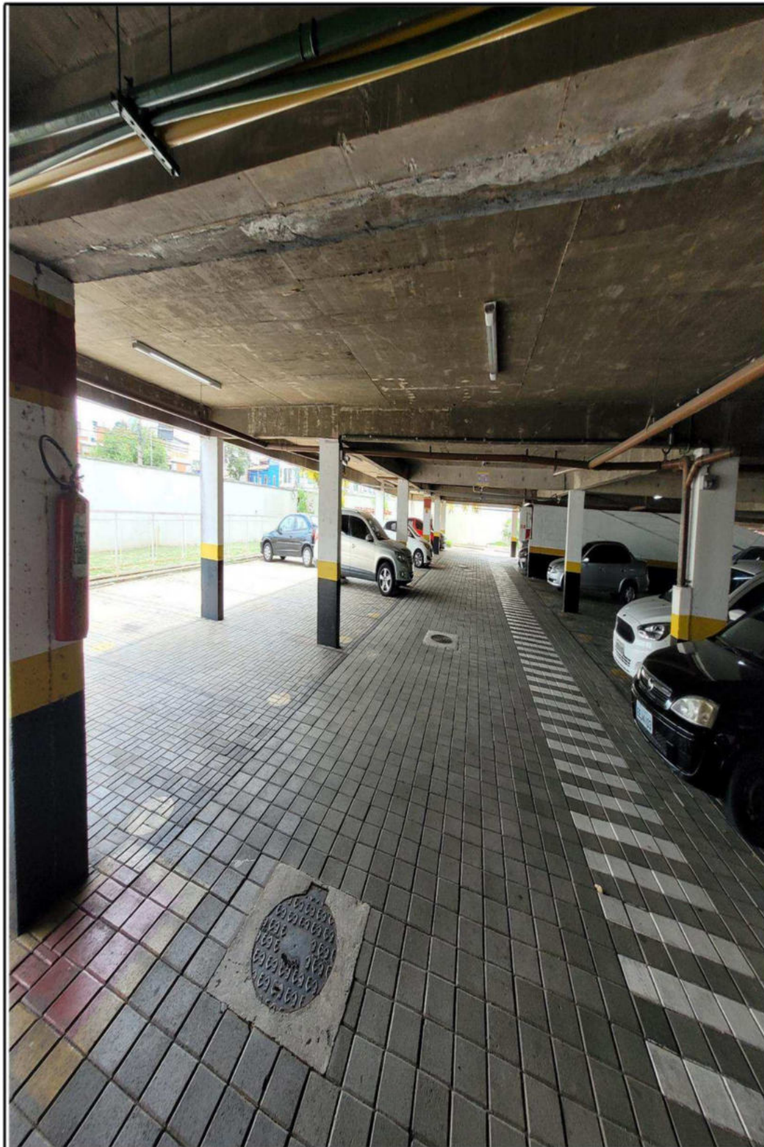
Foto 15 - Vista das vagas de garagem.
