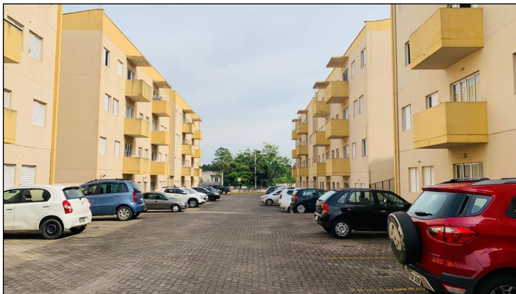
Foto 3: Área externa - Fonte: Própria – Data: 23/02/2023.
