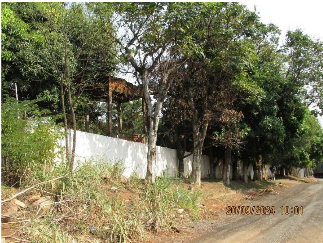
Fachada Imóvel Periciando
