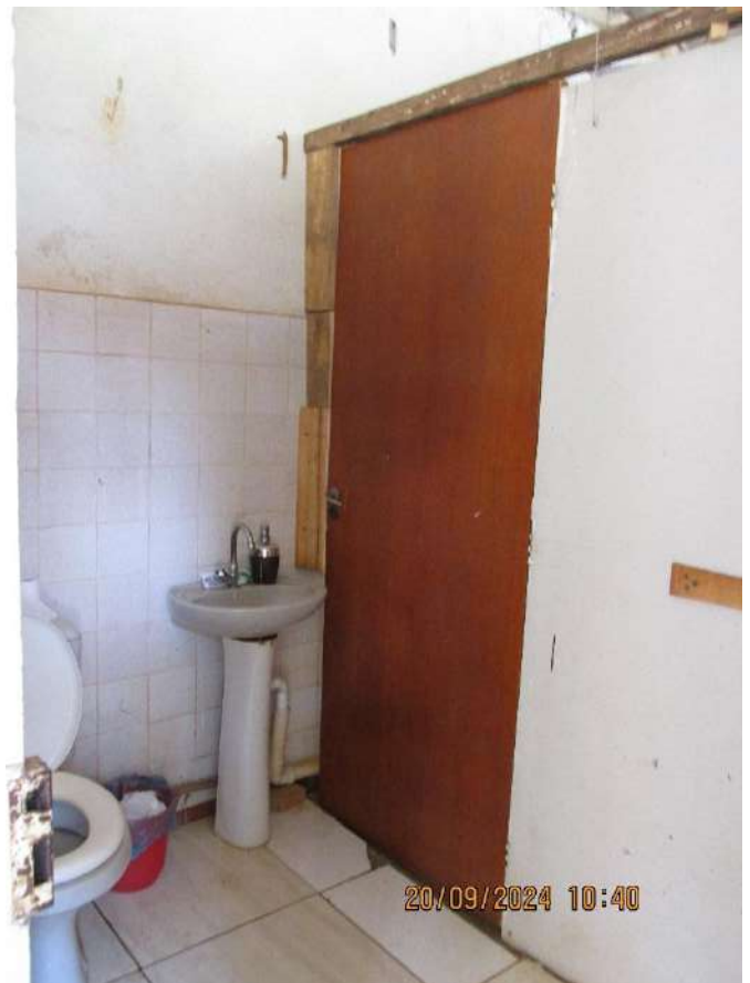
Banheiro/Área de Lazer/Salão
