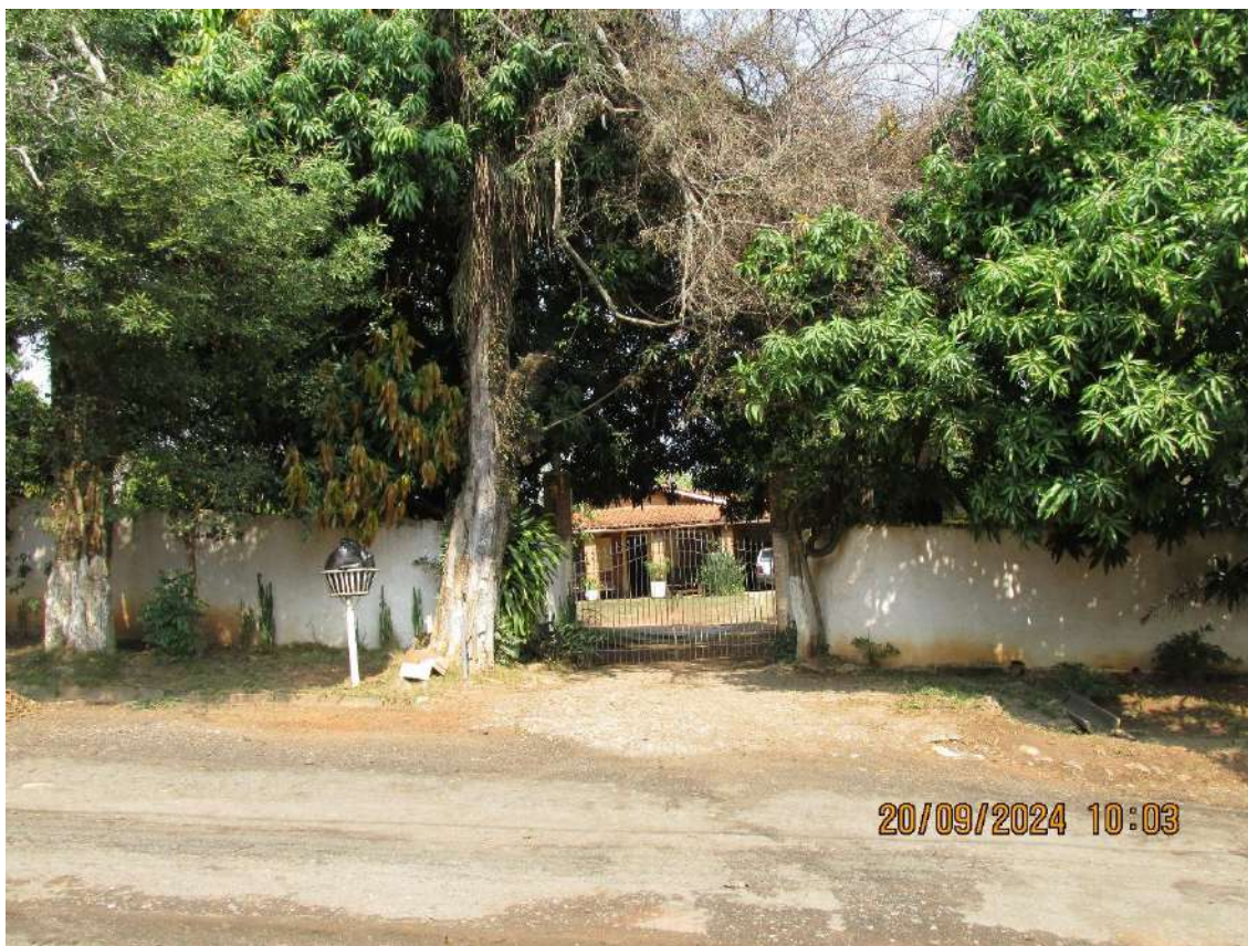
Fachada Imóvel Periciando
