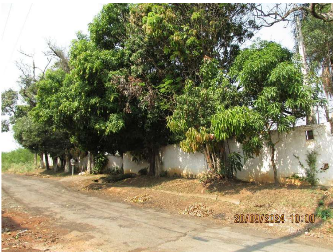
Fachada Imóvel Periciando
