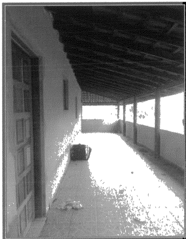
Casa de caseiro 1: Varanda.
