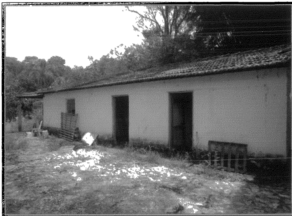
Casa de caseiro 1: Vista externa.
