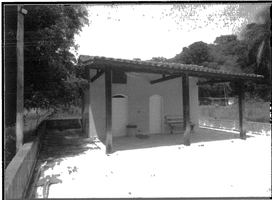
Sauna / banheiro: Vista externa.
