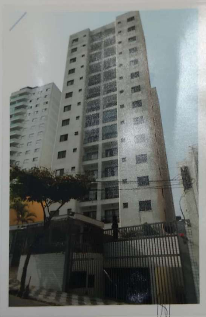
Outra vista da fachada do Condomínio Edifício Maison Tuileries, de quem olha da Rua dos Democratas.
