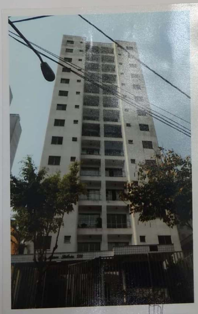
Vista da fachada do Condomínio Edifício Maison Tuileries, de quem olha da Rua dos Democratas.
