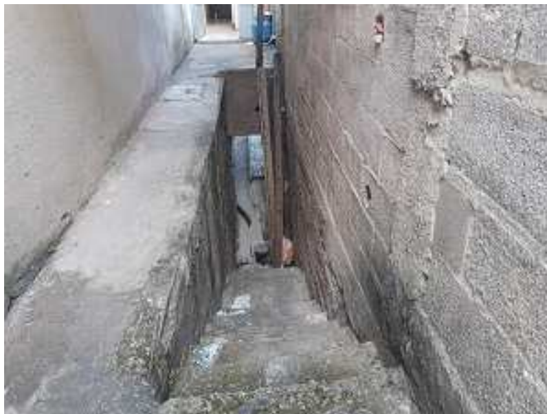
FOTO 29 – ACESSO PARA O PISO TERREO
