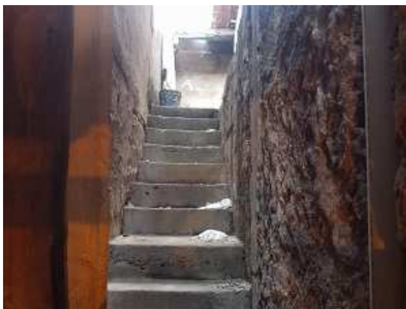
FOTO 10 – ESCADA ACESSO PARA O PISO SUPERIOR
