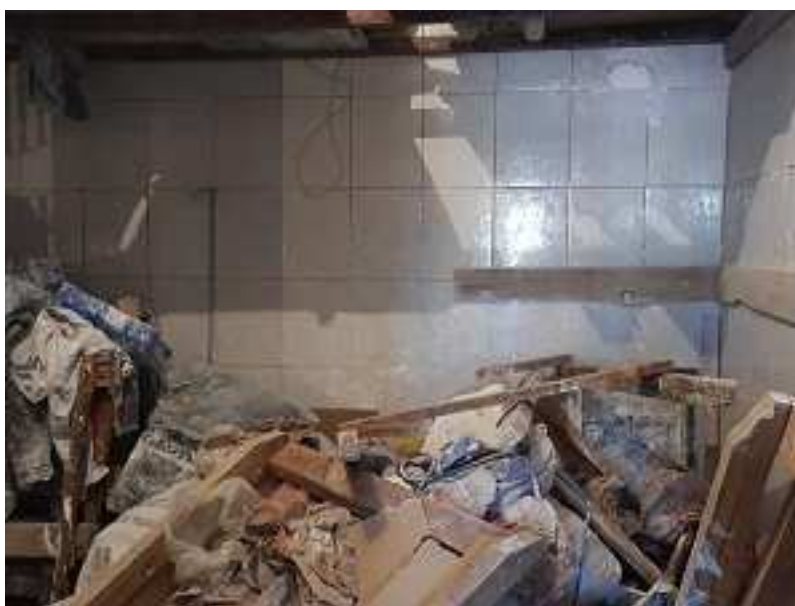
FOTO 08 – VISTA DO PORÃO
