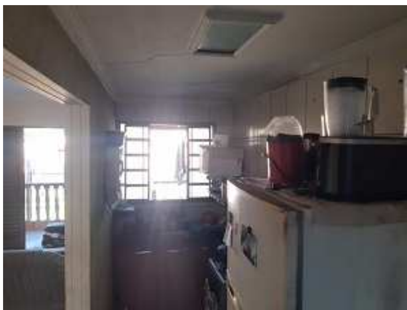
FOTO 13 – VISTA DA COZINHA
