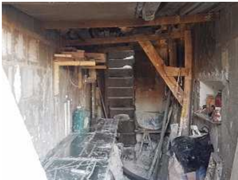
FOTO 04 – PISO TERREO LATERAL
