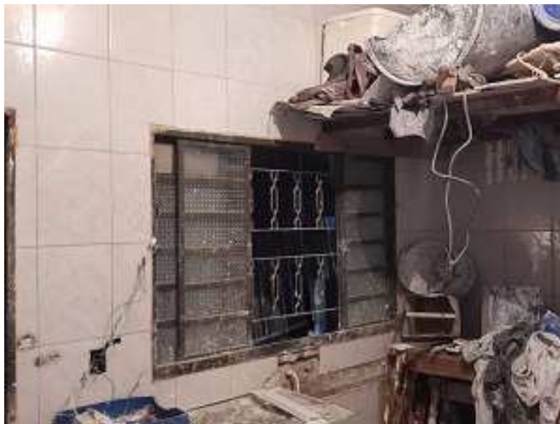
FOTO 09 – VISTA DO PORÃO
