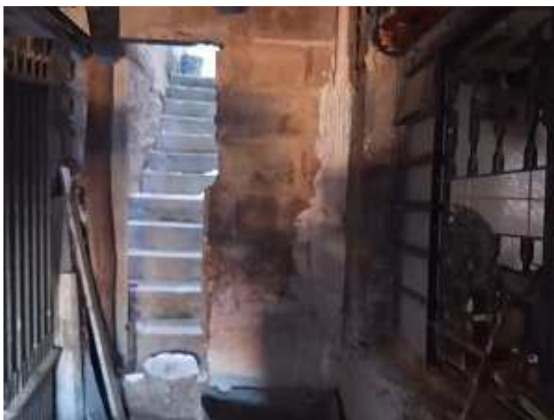
FOTO 06 – VISTA DA LATERAL
