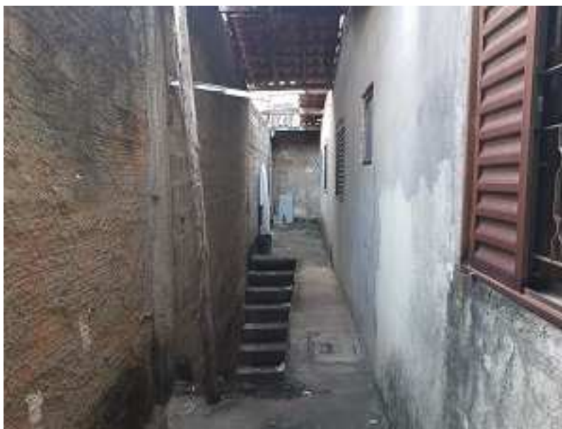
FOTO 26 – LATERAL PISO SUPERIOR
