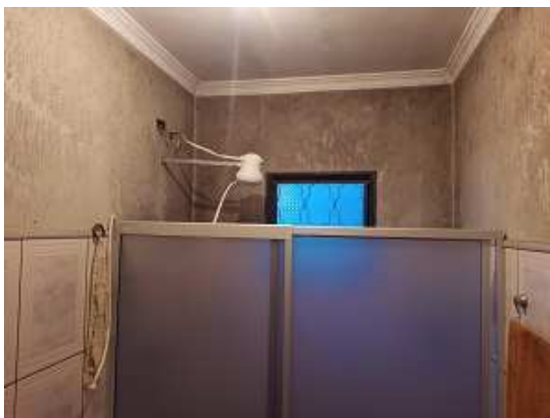
FOTO 19 – VISTA BOX BANHEIRO SOCIAL
