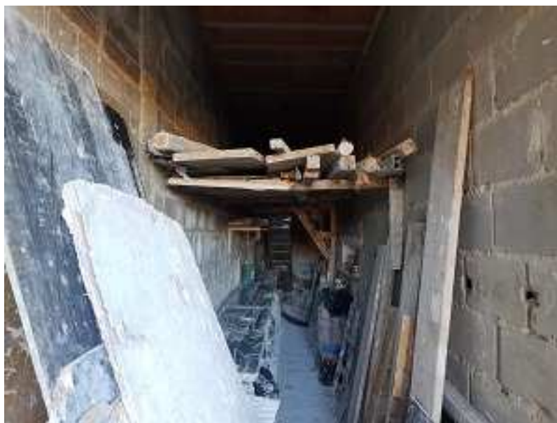
FOTO 03 – PISO TERREO LATERAL
