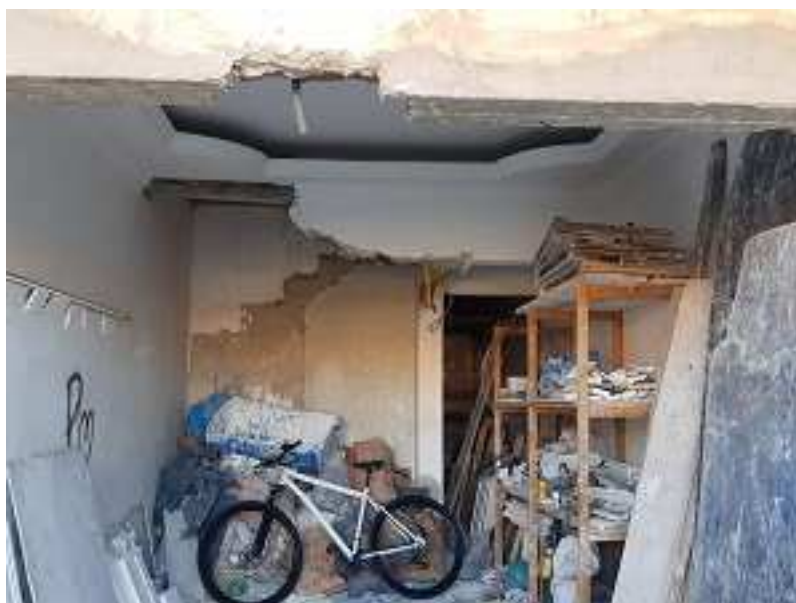
FOTO 05 – PISO TERREO PORÃO
