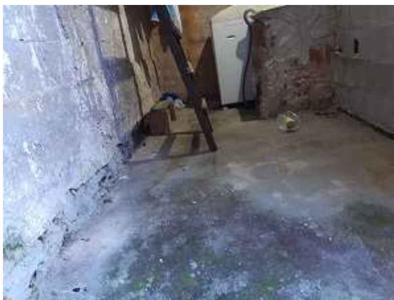
FOTO 28 – VISTA ÁREA DE SERVIÇO
