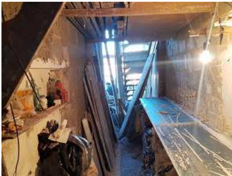
FOTO 07 – VISTA DA LATERAL
