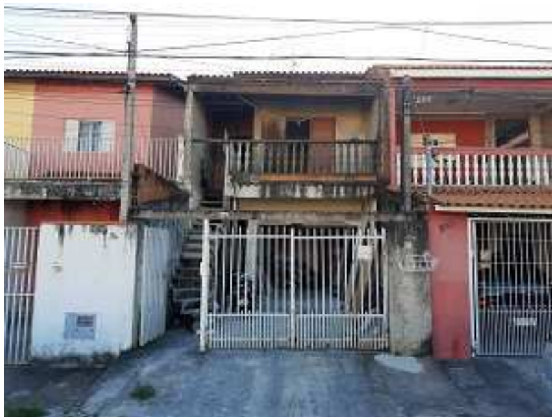
FOTO 37 – FACHADA DO IMÓVEL
