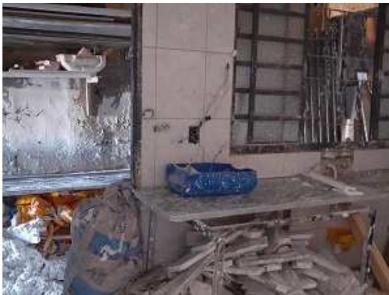
FOTO 06 – VISTA INTERNA DO PORÃO
