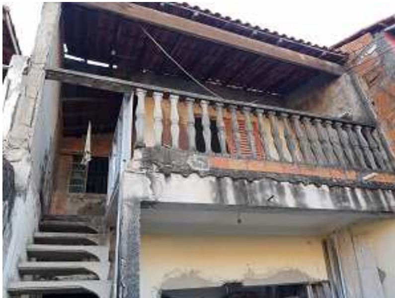
FOTO 35 – VISTA ACESSO PISO SUPERIOR
