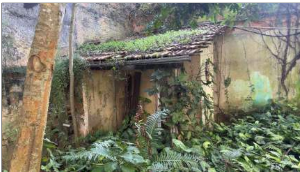
Pequena construção aos fundos para demolição
