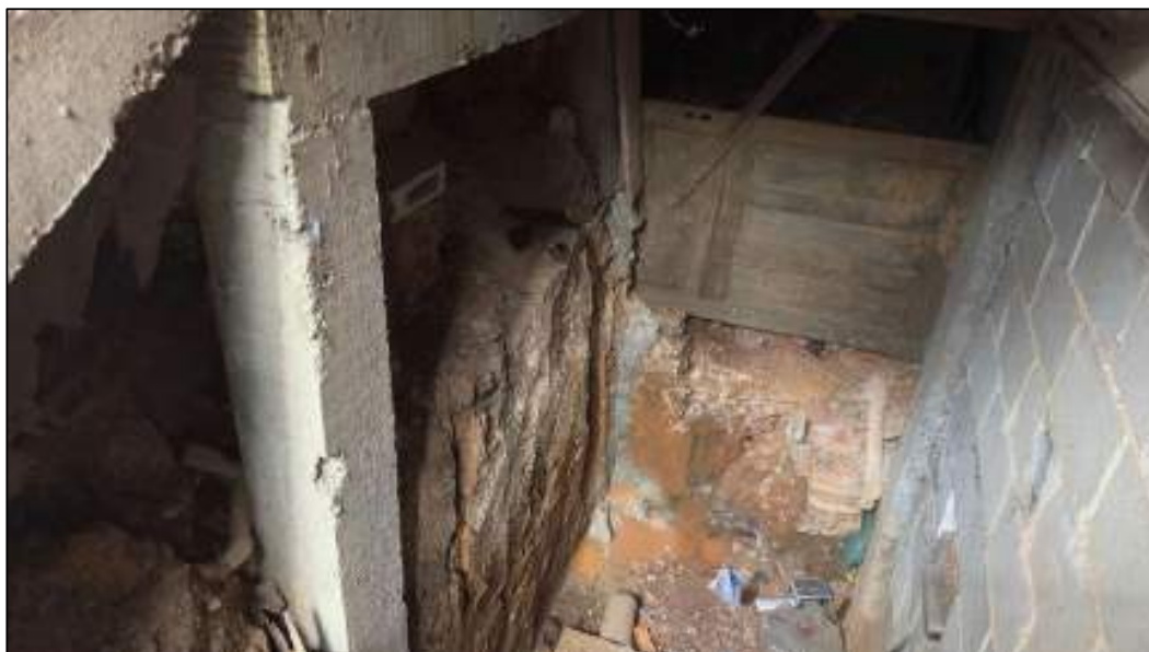
Vista geral da estrutura e fundação, com calças e sem nenhuma contenção
