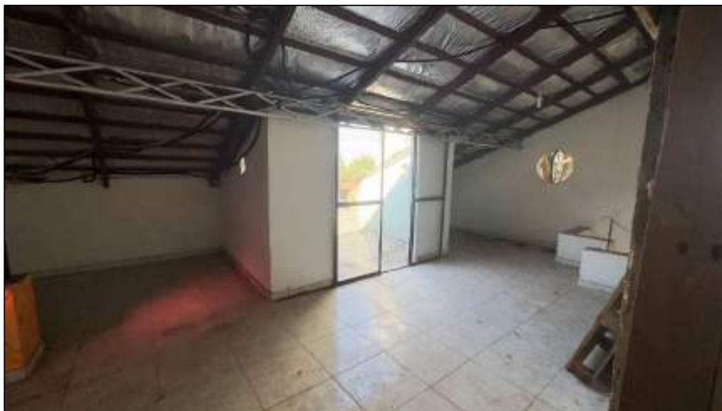
Vista geral da construção inacabada – Pavimento superior
