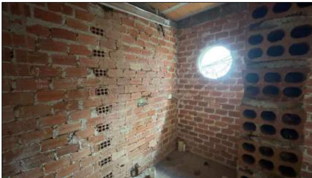
Vista geral da construção inacabada
