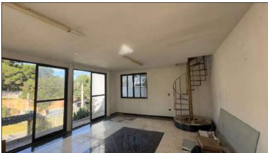
Vista geral interna do imóvel
