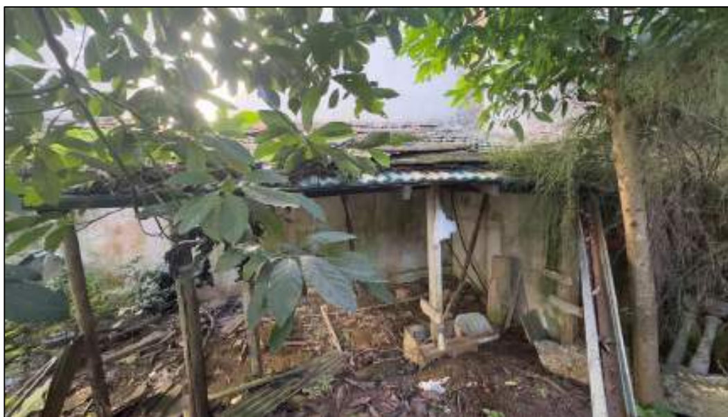
Vista geral de cobertura para demolição
