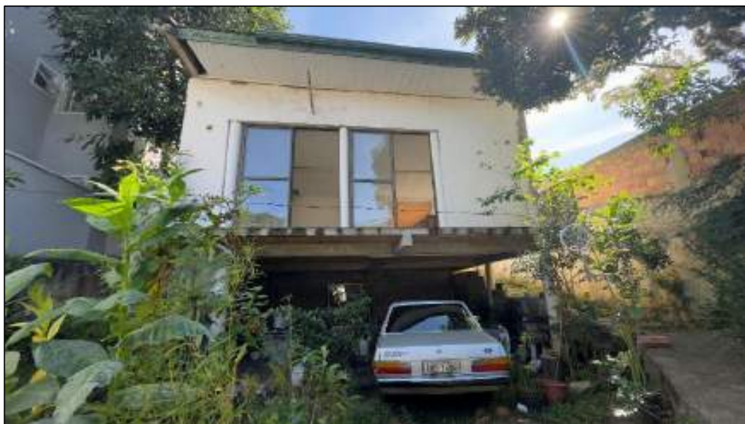
Vista geral do imóvel
