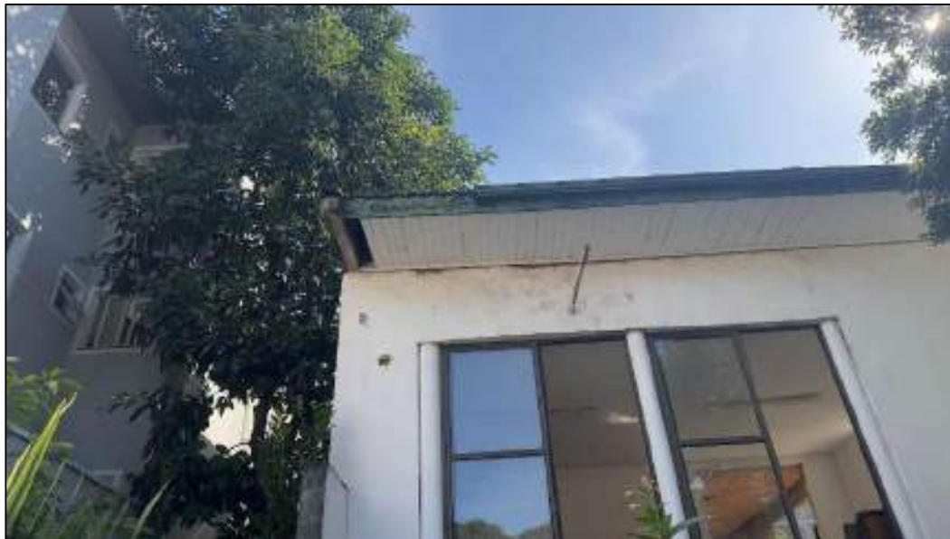
Vista geral da situação da construção
