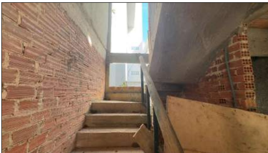
Vista geral da construção inacabada
