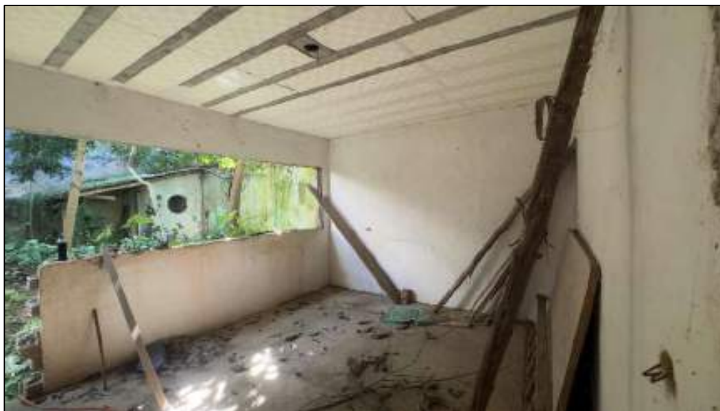
Vista geral da construção inacabada
