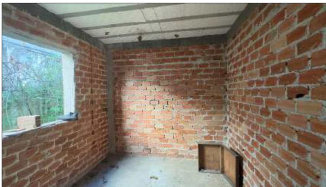
Vista geral da construção inacabada
