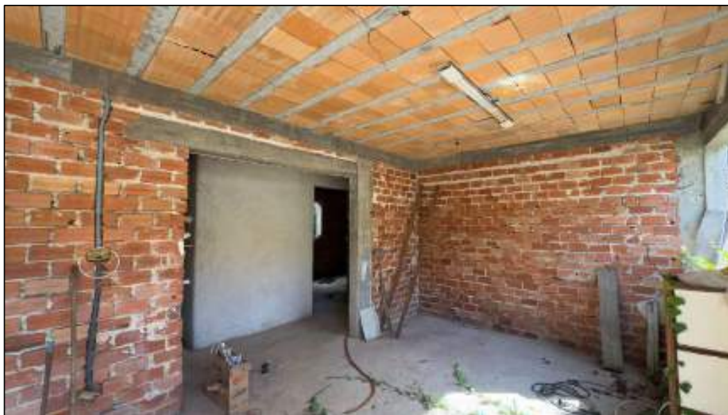
Vista geral da construção inacabada
