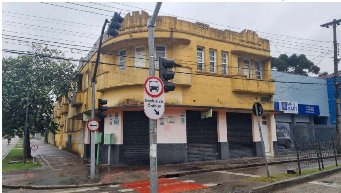
Vista do Imóvel Avaliando
