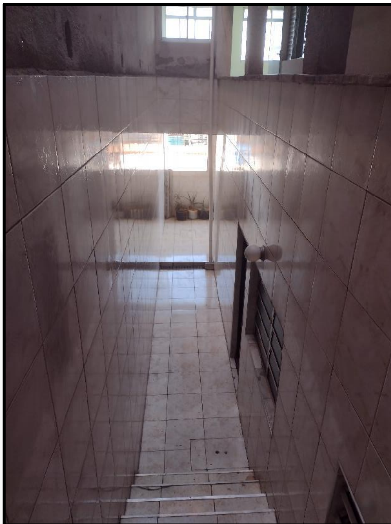
VISTA DO CORREDOR DE ACESSO AO IMÓVEL DO 2º SUBSOLO.
