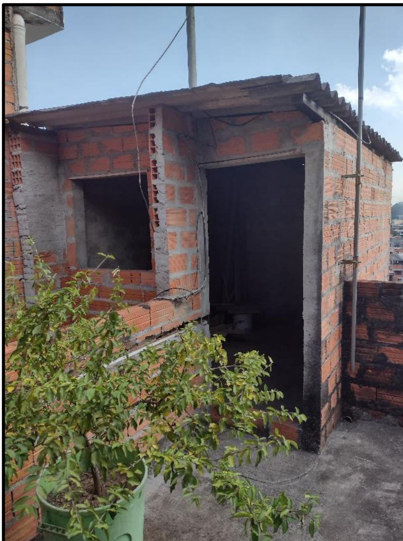
VISTA DO DEPÓSITO.
