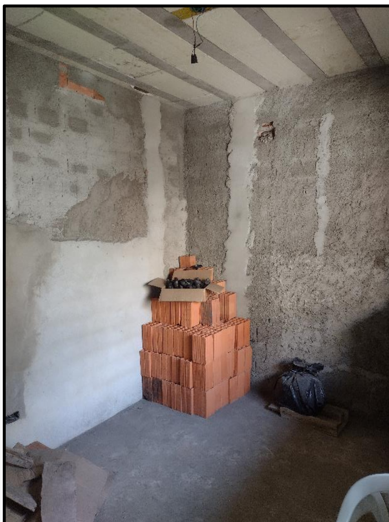
VISTA DO DORMITÓRIO.
