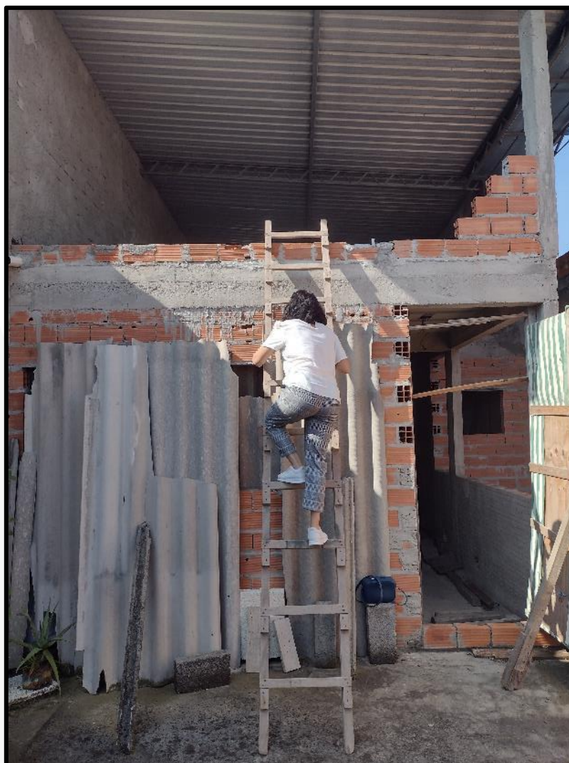
VISTA DO ACESSO À COBERTURA.
