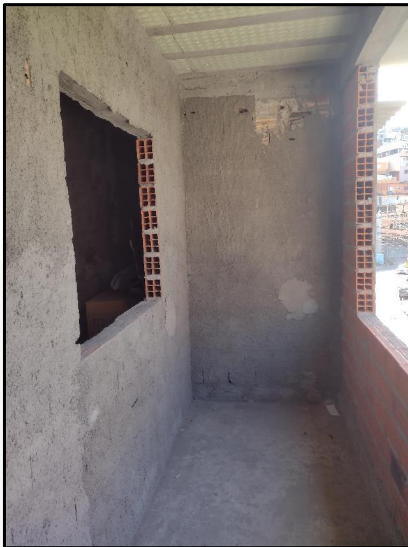
VISTA DA ÁREA.
