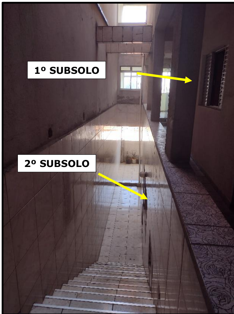
ESCADA DE ACESSO AO 1º E 2º SUBSOLO.
