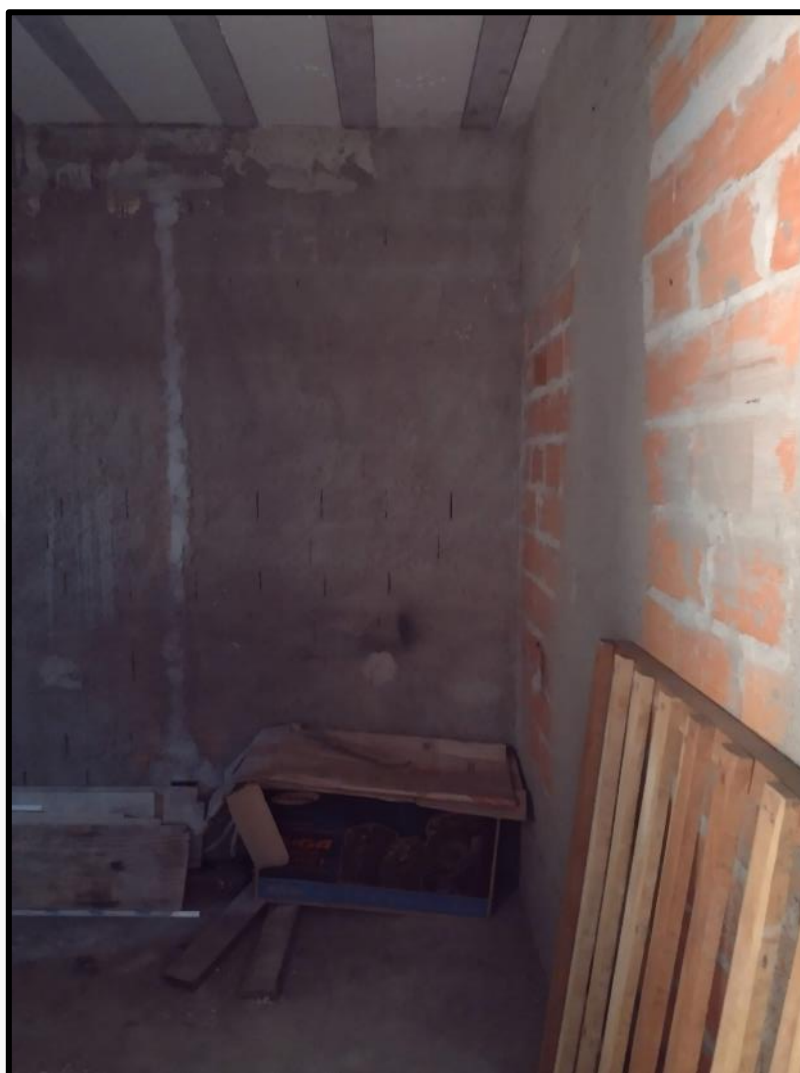
VISTA DO DORMITÓRIO.
