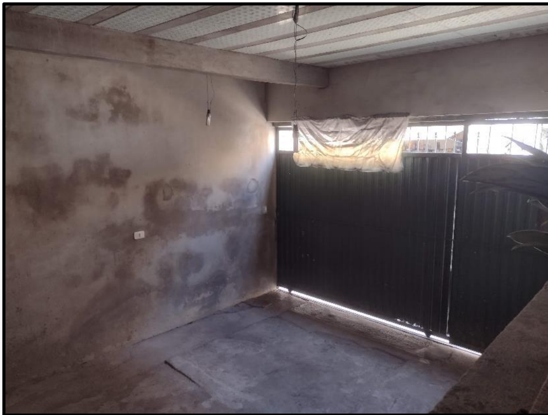
VISTA DA GARAGEM.
