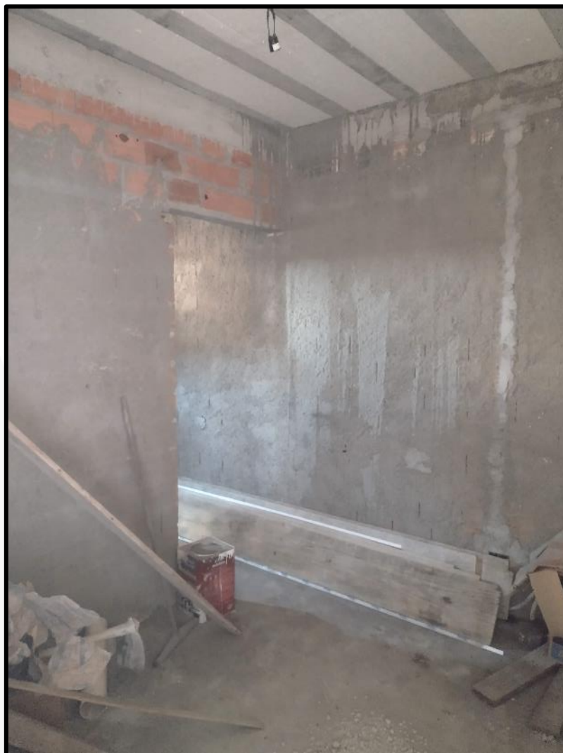
VISTA DO DORMITÓRIO.
