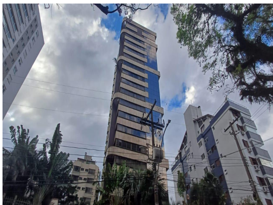
VISTA DA FACHADA DO IMÓVEL EM ESTUDO
