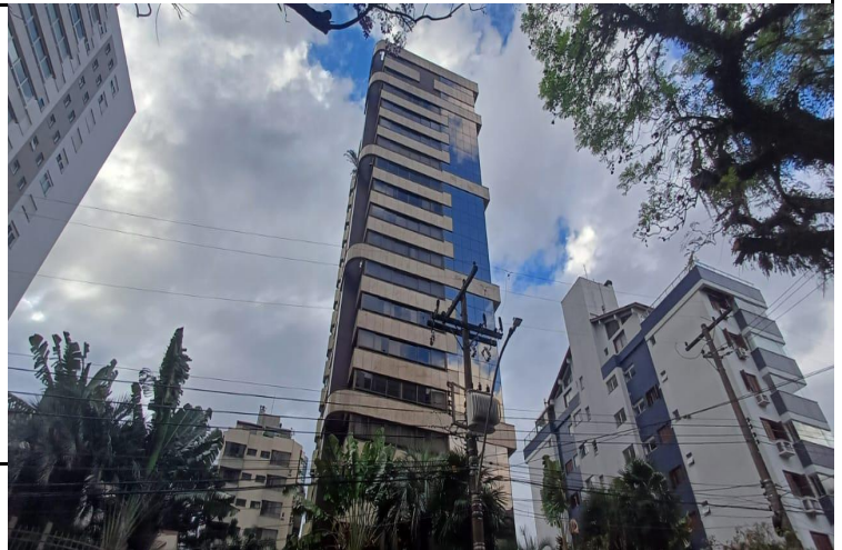
Foto da Fachada do Imóvel
