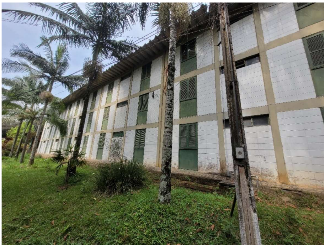
FOTO 10 – Prédio de apartamentos
