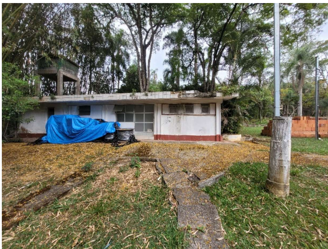
FOTO 20 – Edificação das saunas e banhos
