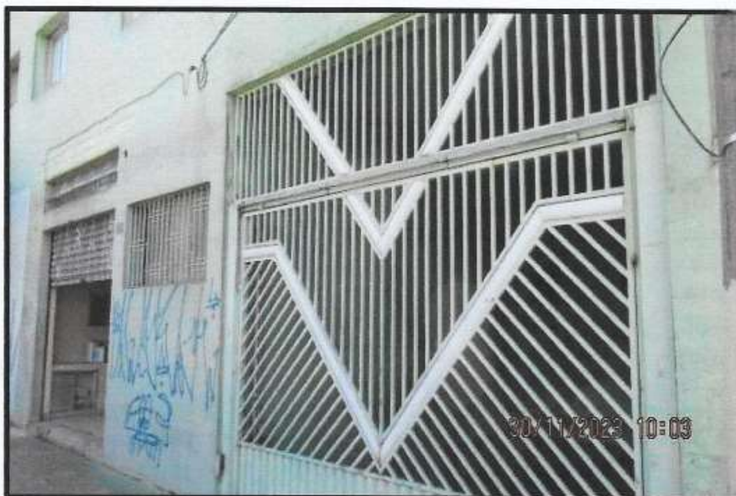
Foto nº 3: Detalhe do portão da garagem do Edifício no qual a unidade avalianda tem direito a uma vaga indeterminada.
