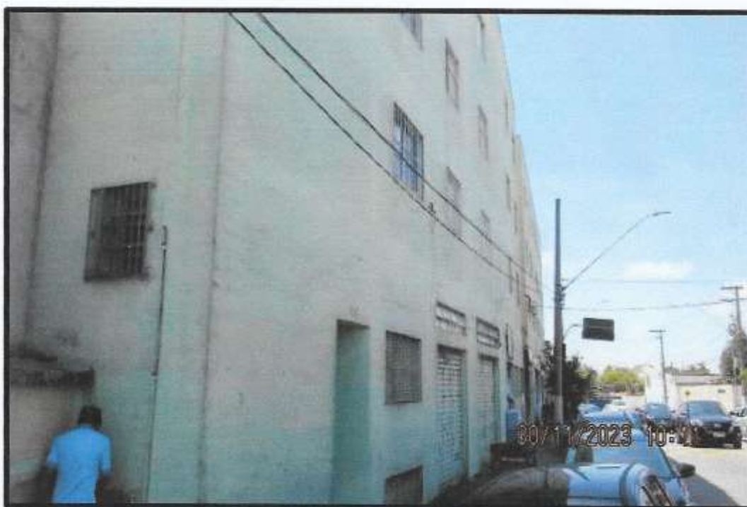
Foto nº 4: Outra vista da fachada do Edifício Boa Vista.
