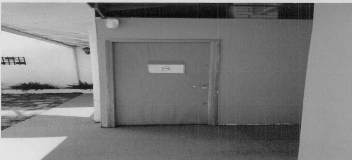
Foto - 44 - Sala de Aula
