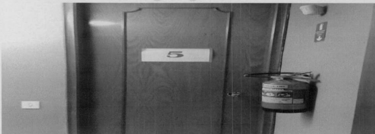
Foto - 59 - Sala de Aula
