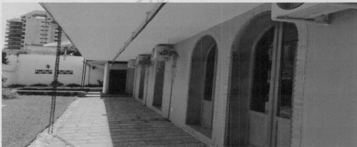
Foto - 38 - Corredor Externo
