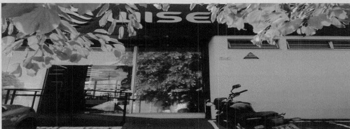
Foto - 15 - Entrada Imóvel
