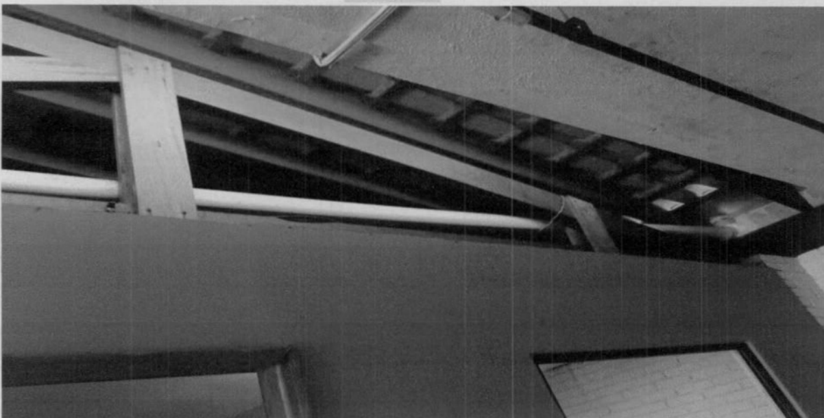
Foto - 48 - Estrutura Telhado
