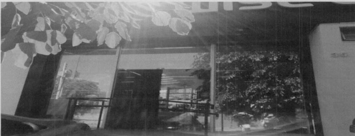
Foto - 16 - Fachada do Imóvel
