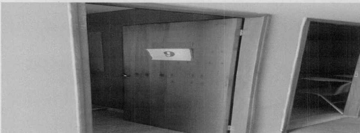
Foto - 45 - Sala de Aula
