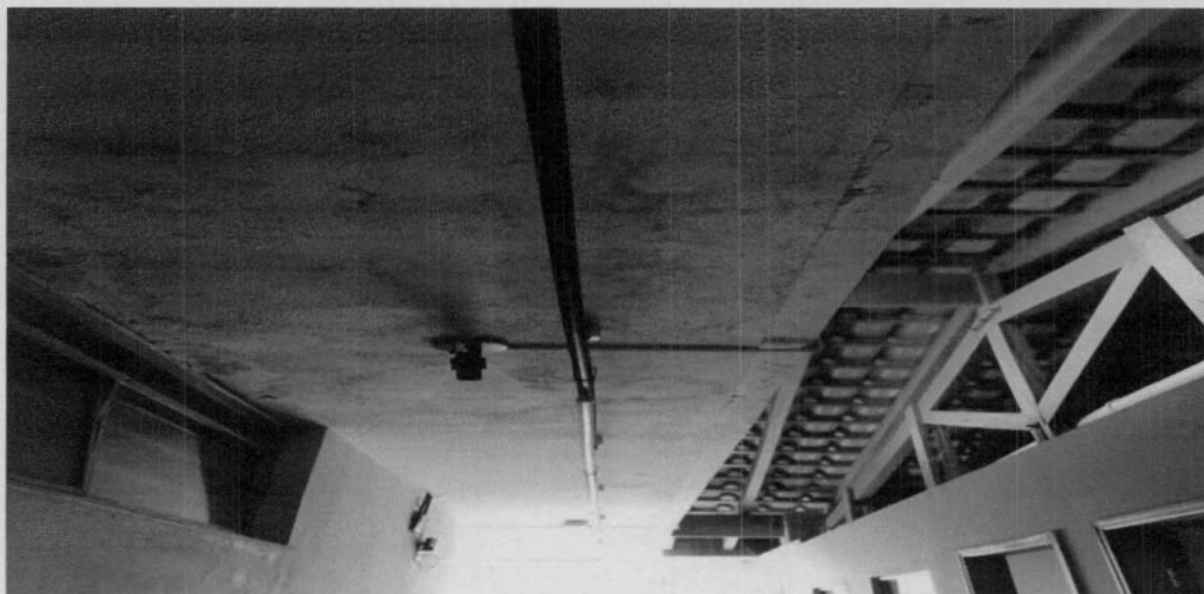
Foto - 49 - Estrutura Telhado
