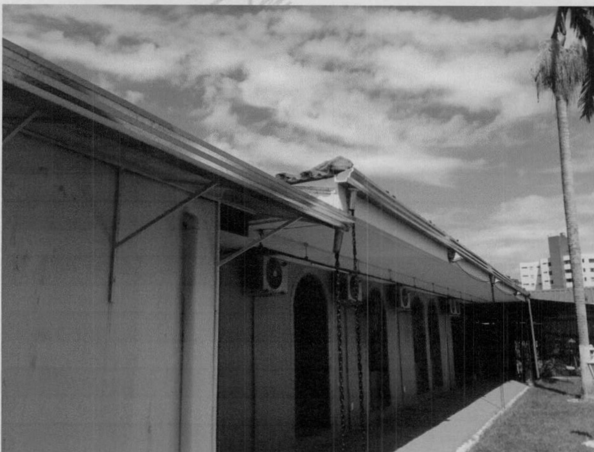
Foto - 53 - Calhas do Telhado Corredor Externo
