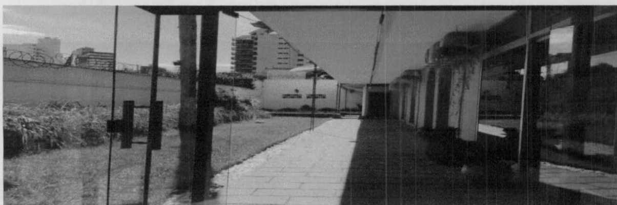
Foto - 39 - Corredor Externo
