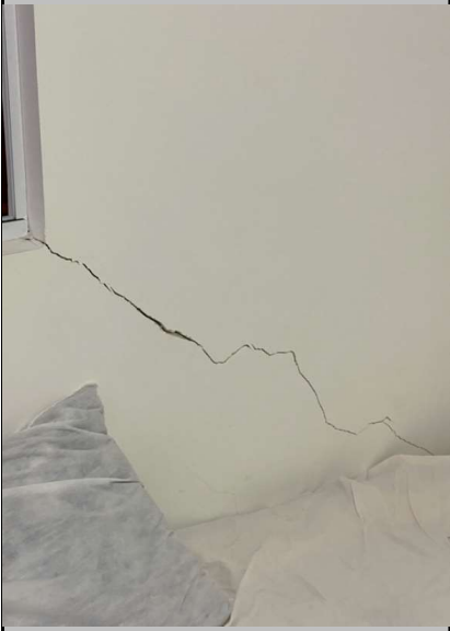
Rachaduras estruturais
