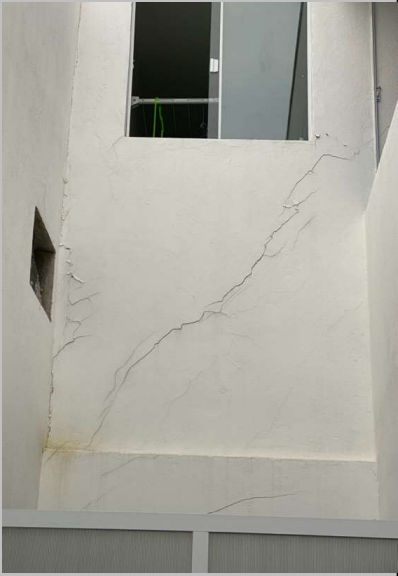
Rachaduras estruturais
