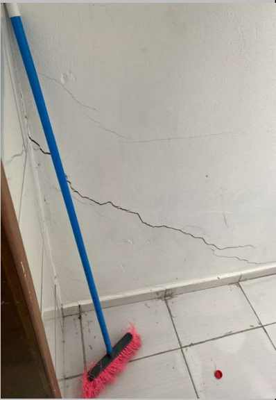
Rachaduras estruturais
