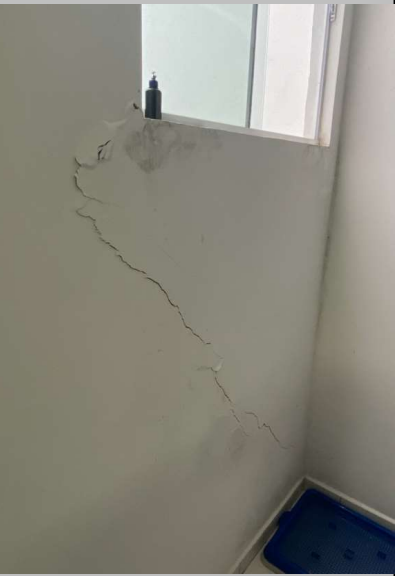
Rachaduras estruturais
