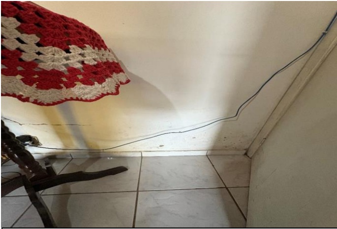
PAREDE DA SALA
