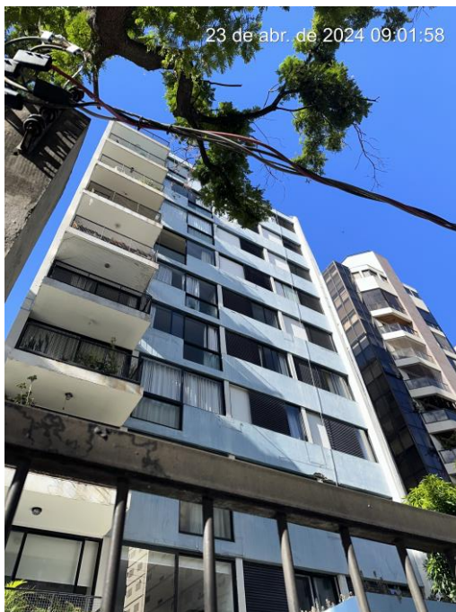
FOTO 01 – Vista geral da fachada do Prédio
