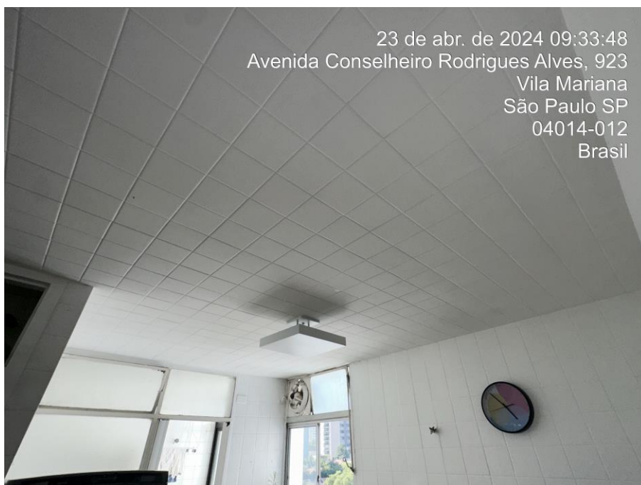
FOTO 07 – Detalhe das paredes e teto revestidos com azulejos brancos.
