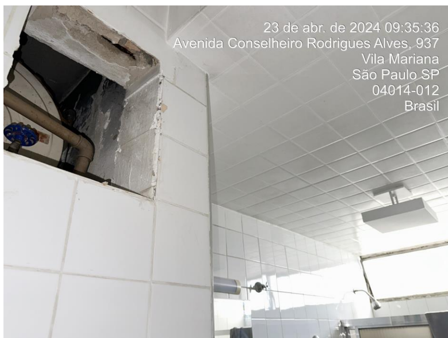
FOTO 19 – Detalhes dos revestimentos das paredes e teto e acesso ao boiler.
