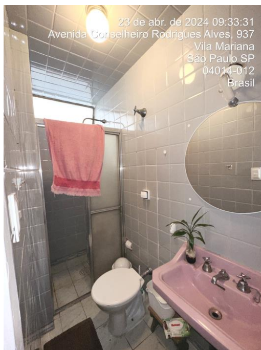
FOTO 04 – Vista geral e detalhes internos do banheiro da entrada.
