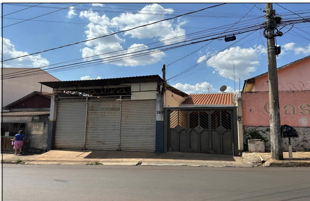
FOTO 01 – Vista frontal do imóvel avaliando
