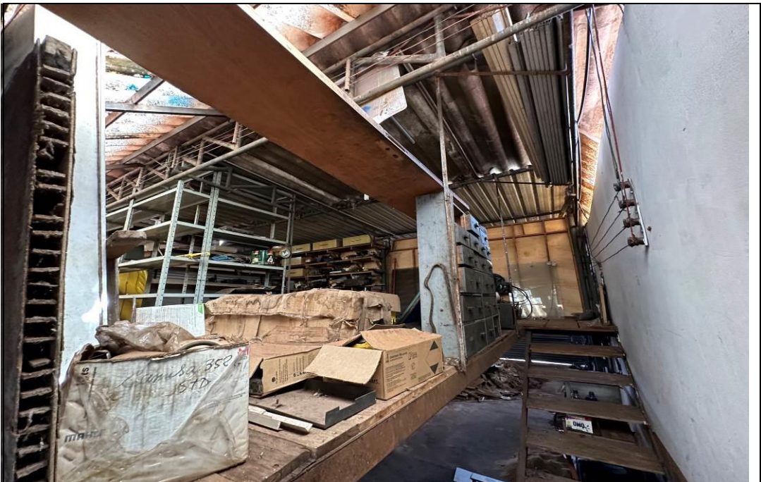
FOTO 15 – Vista geral do mezanino na parte superior do imóvel.
