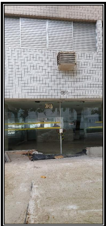
Figura 5 – Entrada do Edifício
