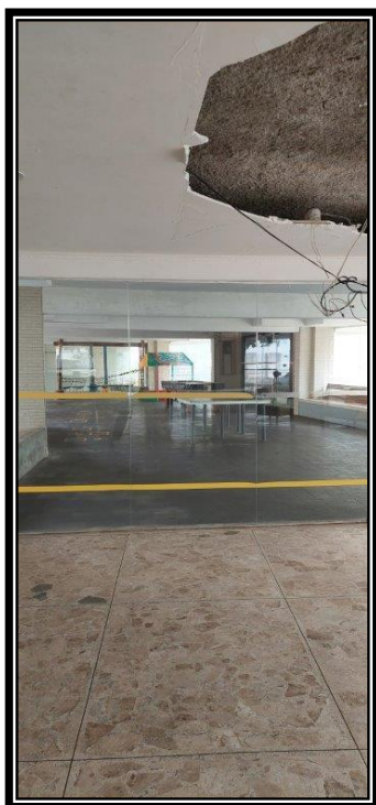
Figura 21 – Área de lazer do edifício
