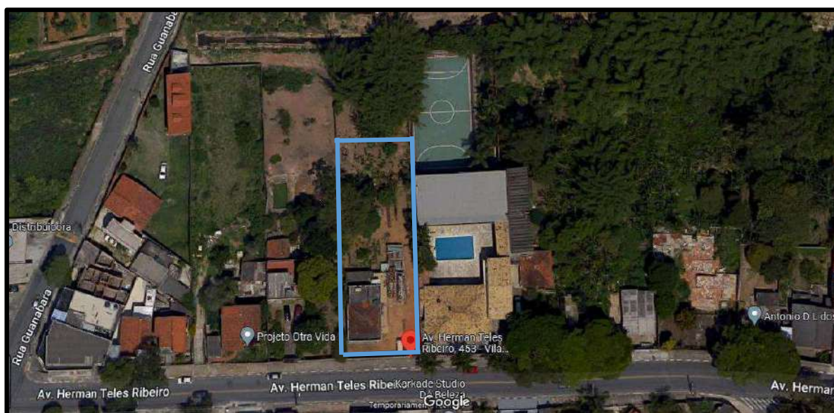
Figura 3: Vista aérea do imóvel
