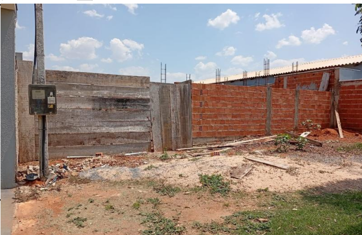
Foto da Fachada do Imóvel
