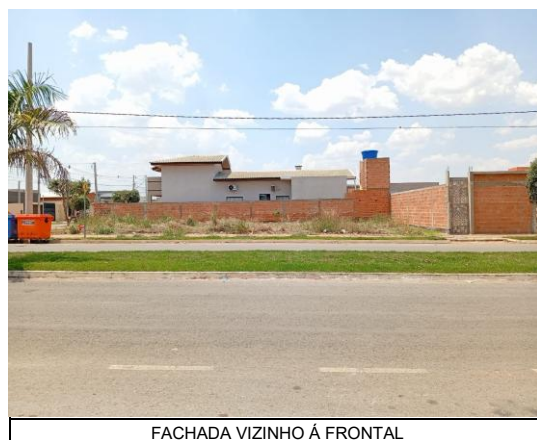
FACHADA VIZINHO À FRONTAL
