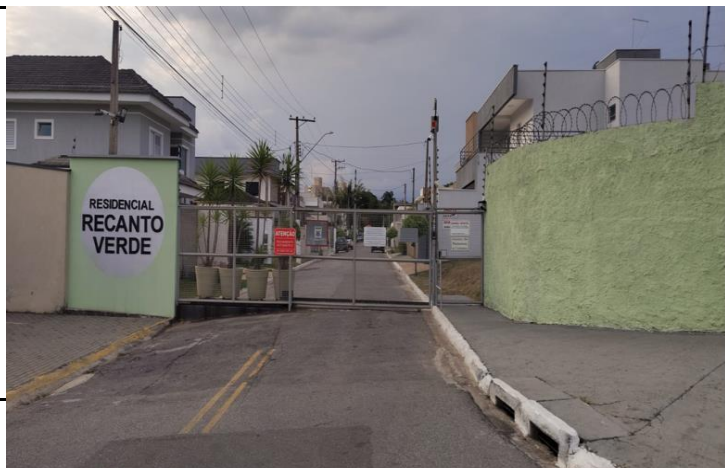
Foto da Fachada do Imóvel
