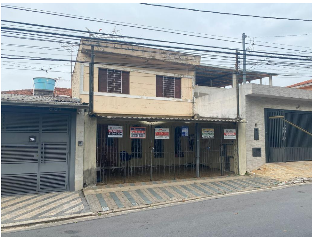
VISTA DA LATERAL ESQUERDA DO IMÓVEL.
