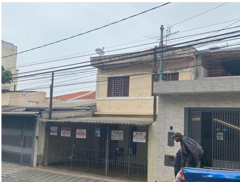
VISTA DA LATERAL DIREITA DO IMÓVEL.
