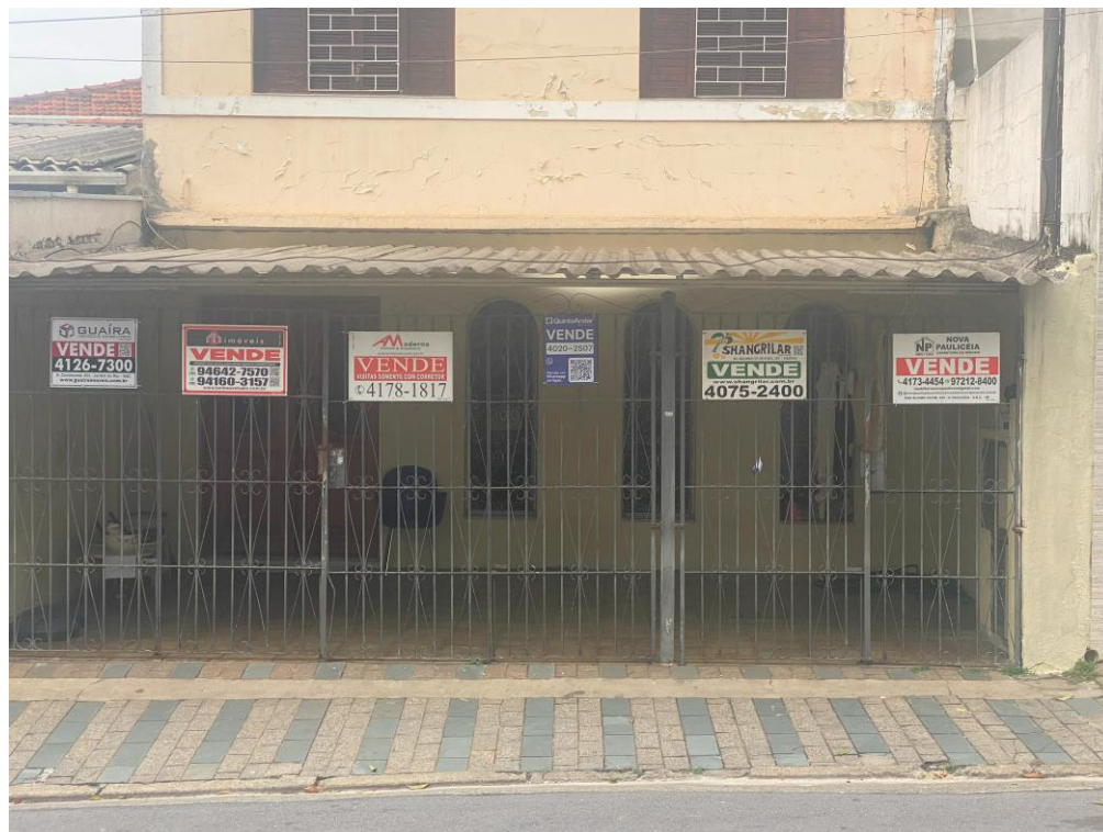
VISTA DO PRIMEIRO PAVIMENTO.
