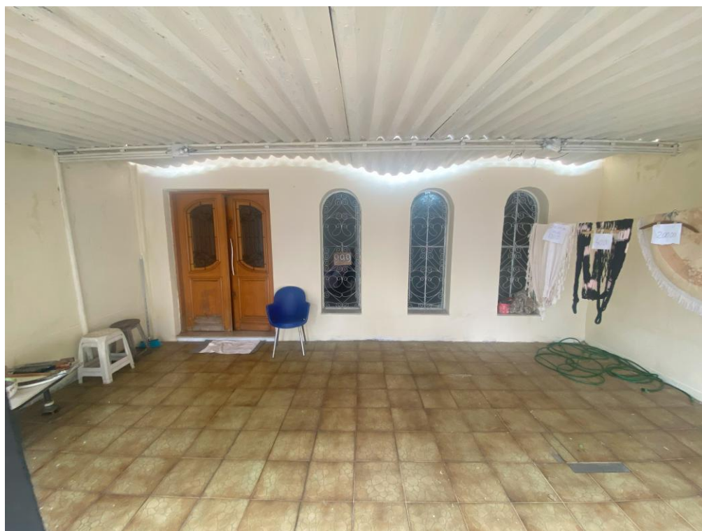
VISTA DA GARAGEM DO IMÓVEL.
