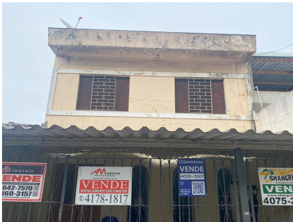
VISTA DO SEGUNDO PAVIMENTO.
