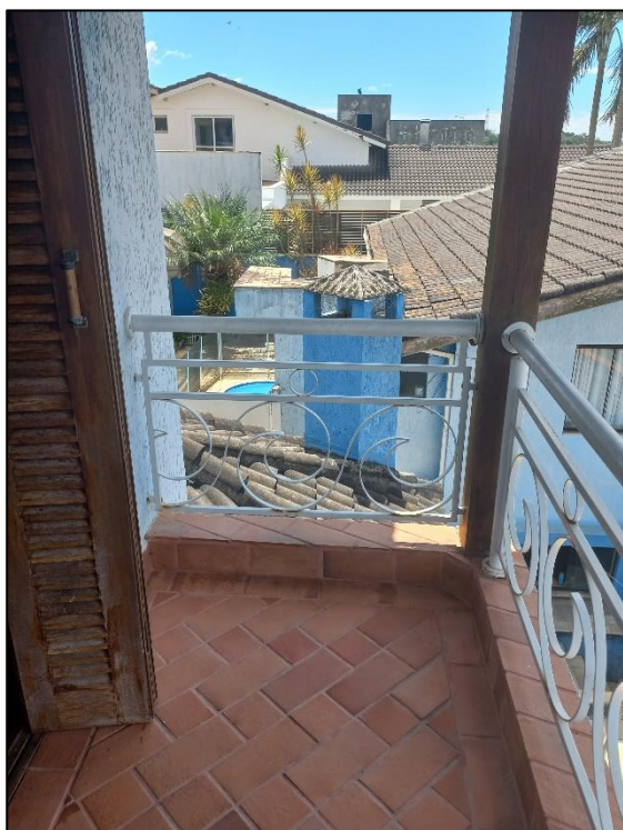
Figura 47: Varanda do quarto dormitório.
