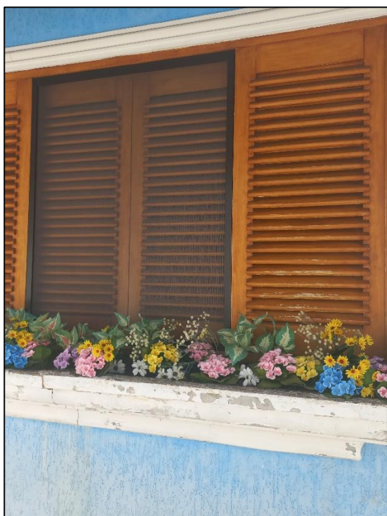
Figura 57: Exterior do imóvel avaliando.
