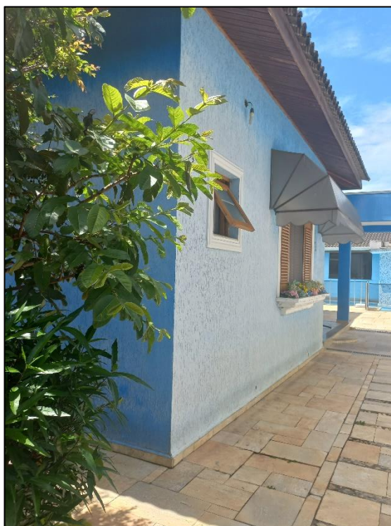
Figura 54: Exterior do imóvel avaliando.
