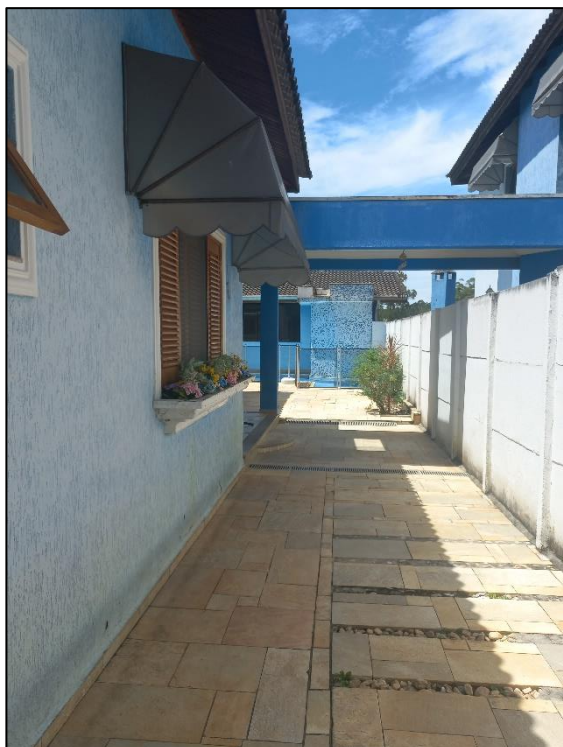
Figura 55: Exterior do imóvel avaliando.
