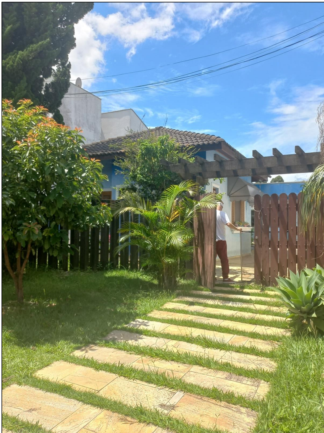
Figura 2: Fachada do imóvel avaliando.
