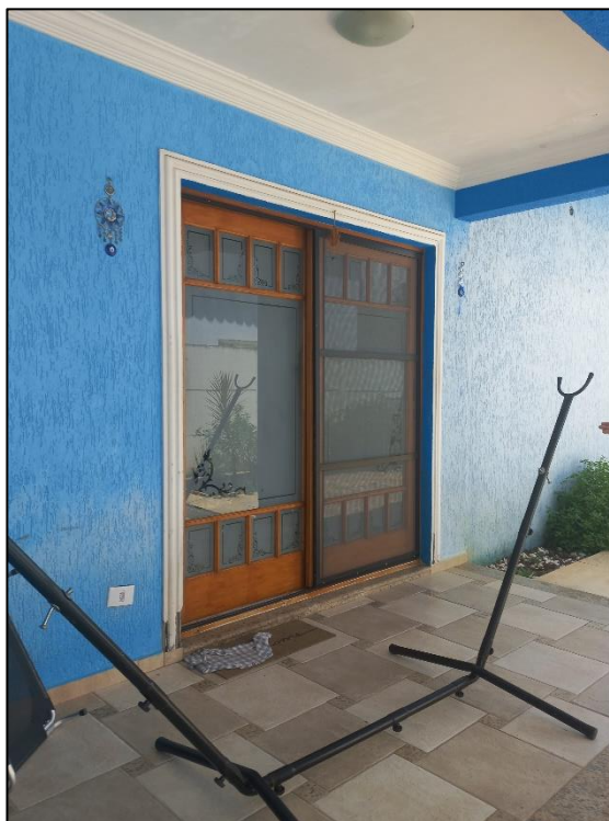
Figura 58: Exterior do imóvel avaliando.
