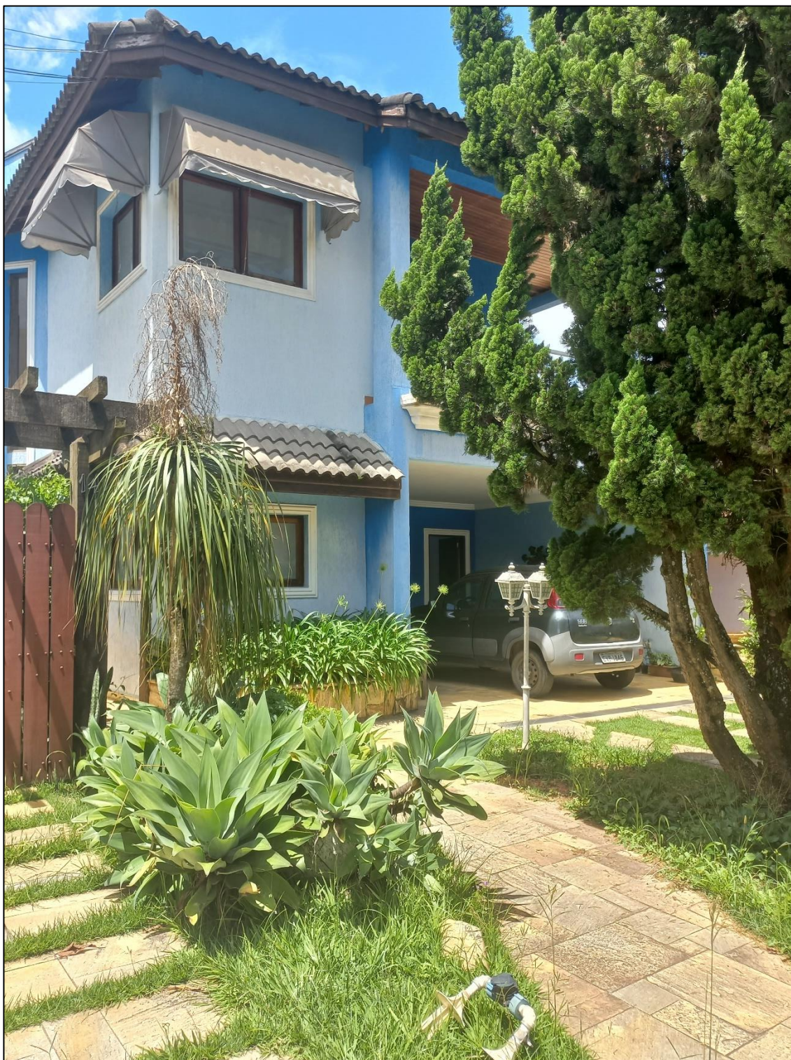
Figura 16: Fachada do imóvel avaliando.
