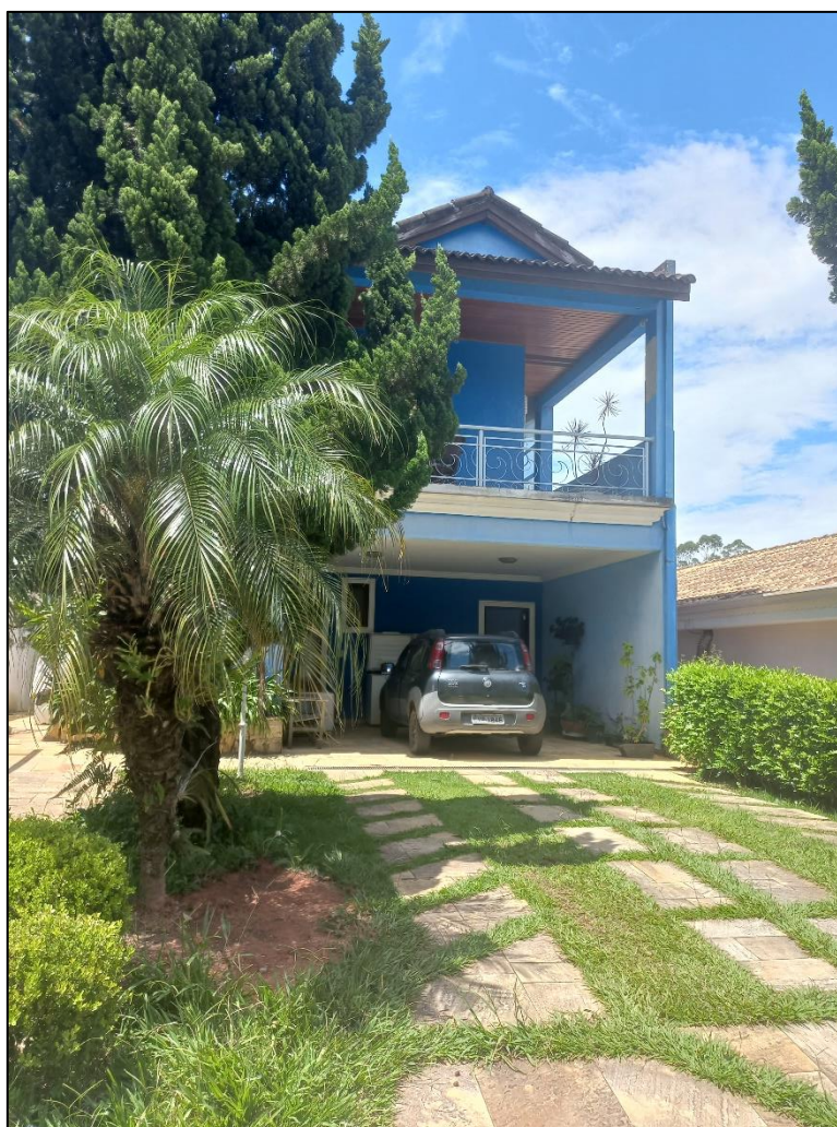
Figura 15: Fachada do imóvel avaliando.
