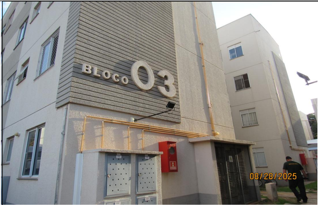
FOTO 02 – Vista frontal do bloco 03, onde o apartamento penhorado está situado.
