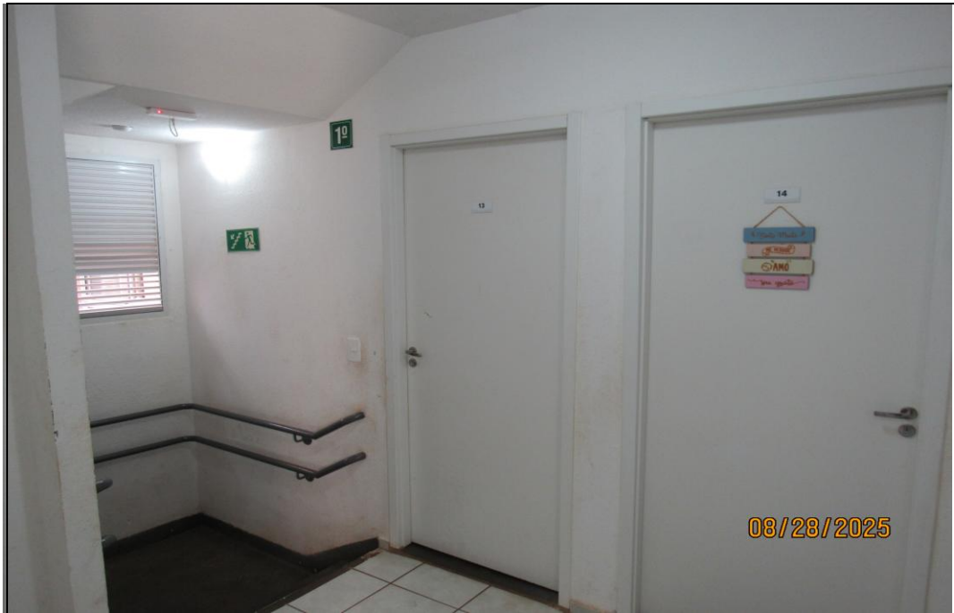
FOTO 05 – Vista da porta de acesso ao apartamento 13, situado no primeiro andar do bloco 03.
