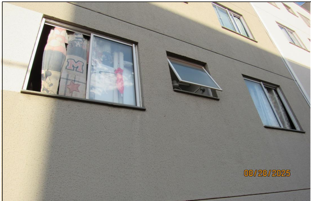
FOTO 03 – Vista externa do apartamento 13, situado no primeiro andar do bloco 03.
