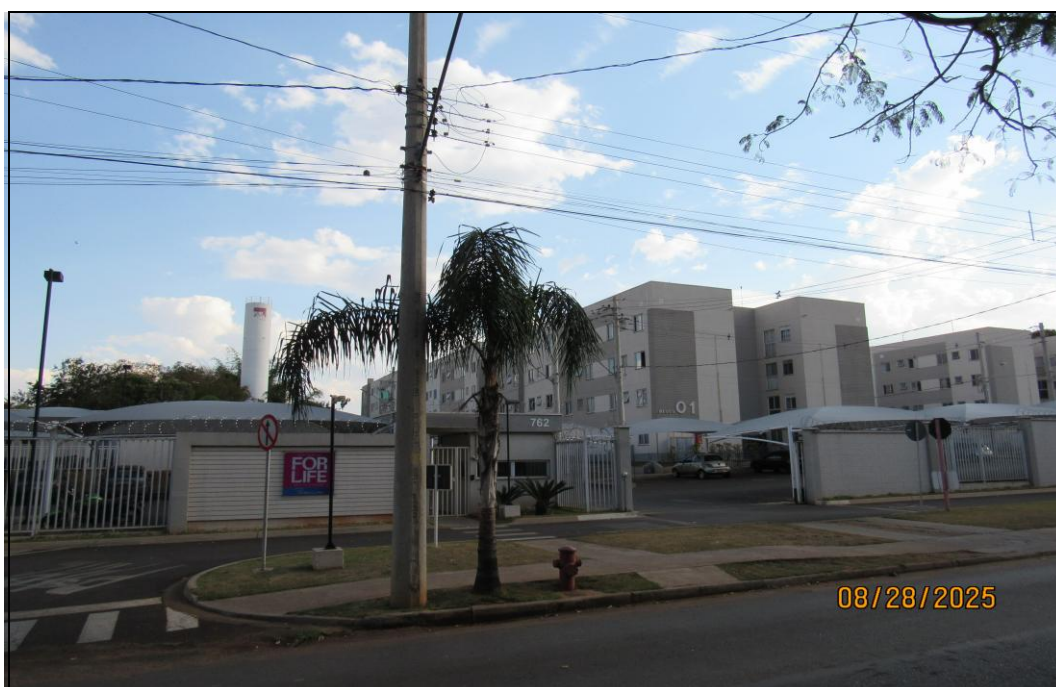
FOTO 01 – Vista geral frontal do Condomínio Residencial Regina Parque.
