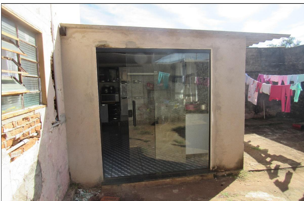
FOTO 14 – Vista externa da cozinha e lavanderia do imóvel.
