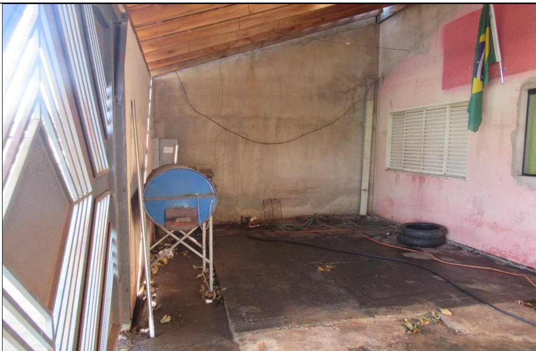
FOTO 03 – Vista geral da garagem do imóvel.
