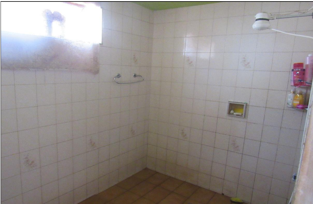
FOTO 08 – Vista geral do banheiro do imóvel.
