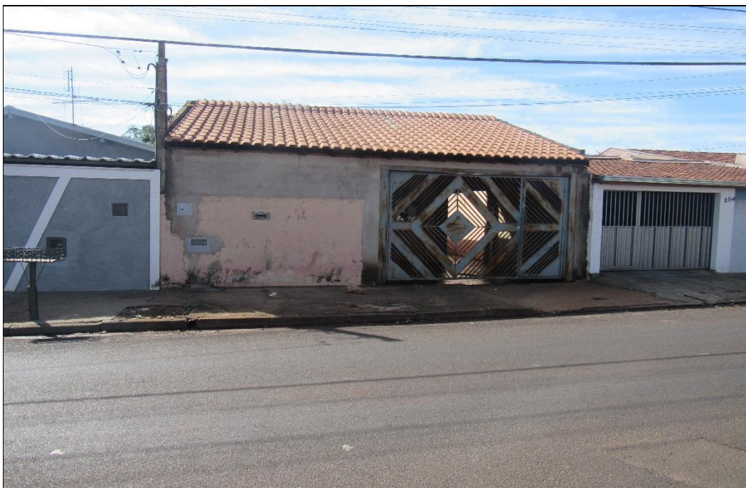
FOTO 01 – Vista geral frontal do imóvel vistoriado.
