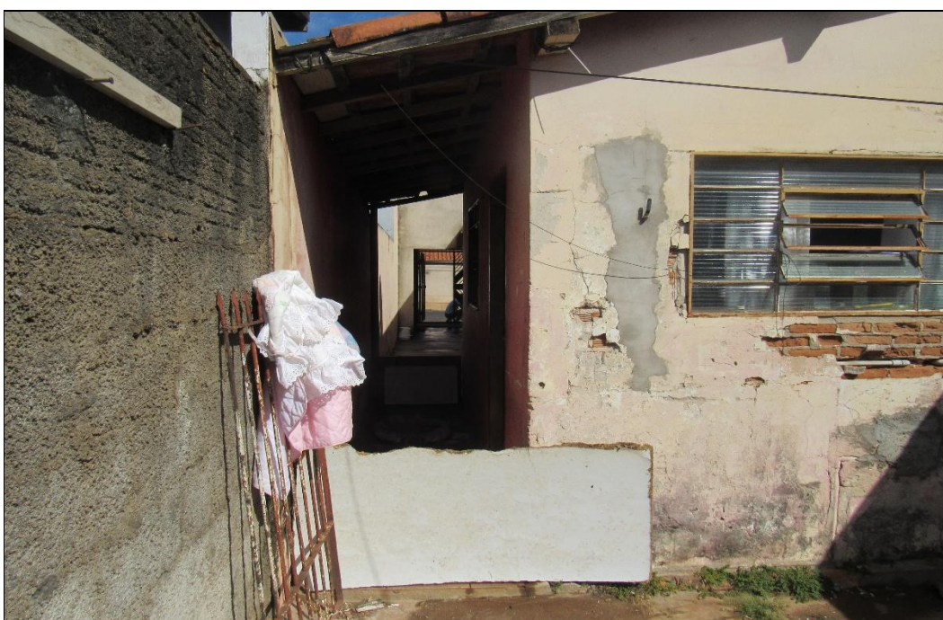
FOTO 16 – Vista do corredor lateral do imóvel.
