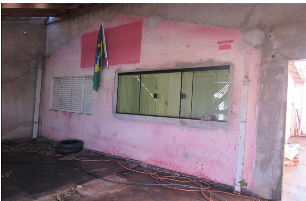
FOTO 02 – Vista geral da garagem do imóvel.
