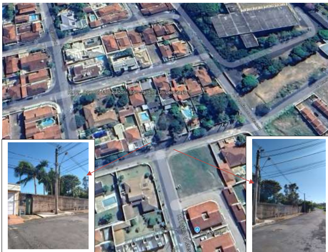
Fotos 10/12 – Vista parcial da situação e vistas parciais da via pública onde se situa o imóvel sub-judice
