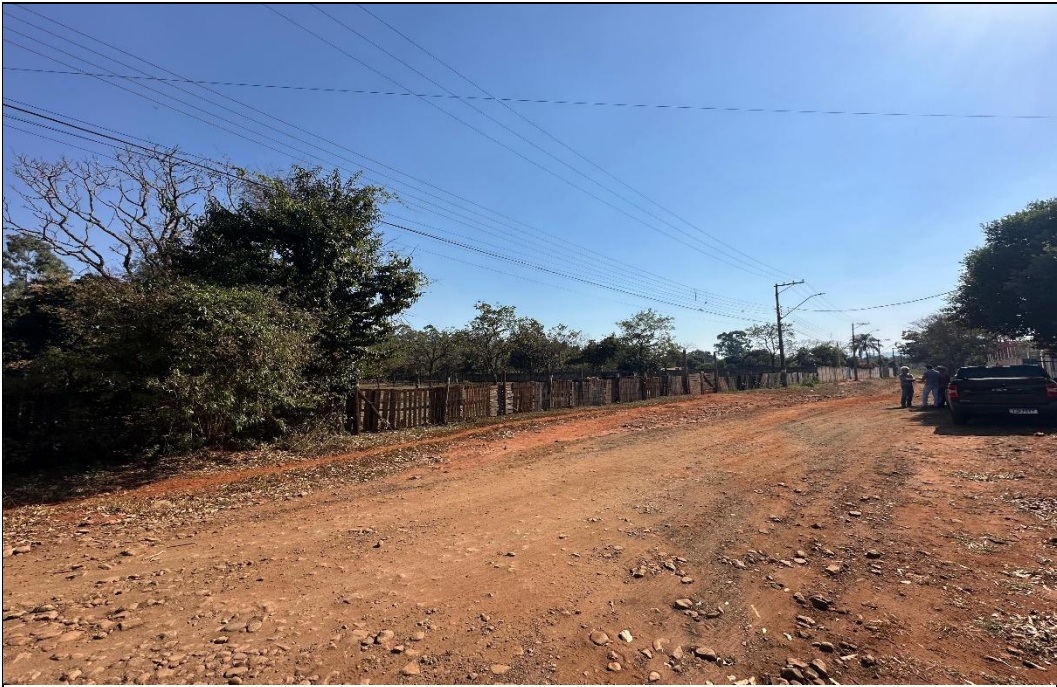
FOTO 01 – Vista geral frontal externa do imóvel vistoriado.
