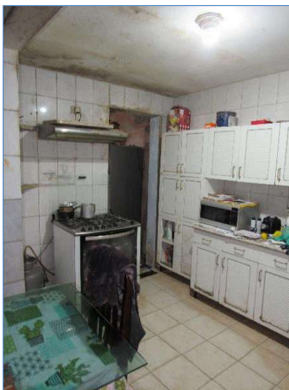
OUTRA VISTA DA COZINHA.
