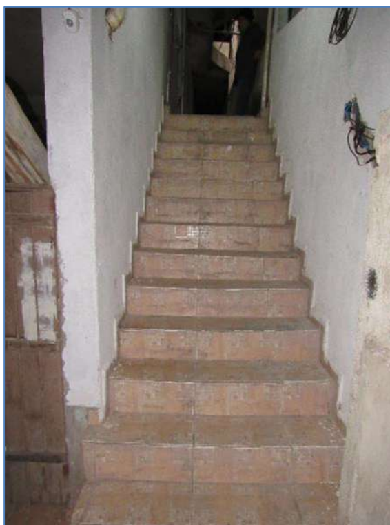
ESCALA DE ACESSO AO 1º PAVIMENTO SUPERIOR.
