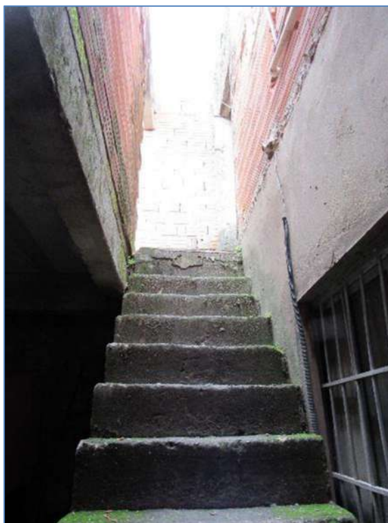
ESCADA DE ACESSO AO PAVIMENTO SUPERIOR.
